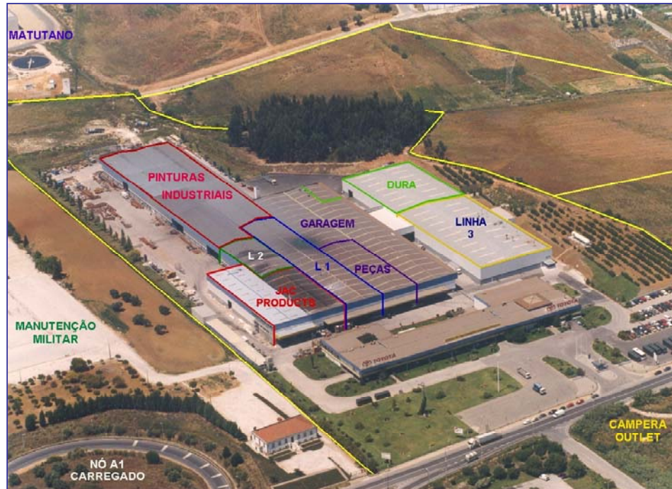
Figura 3 – Vista geral das instalações antes da ampliação do edifício de pinturas industriais e construção do novo edifício para pintura com tintas líquidas
