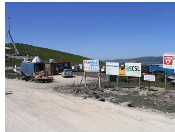
Figura 15 – Aspecto de um estaleiro
