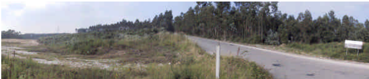
Foto 4 – Vista para norte, em direcção às soluções 1 e 2 (e início da alternativa 1) a norte do aglomerado da Carvalhosa. Esta estrada será atravessada da esquerda para a direita aproximadamente neste ponto.
