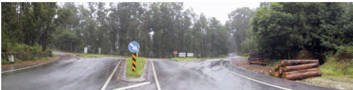
Foto 20 – Vista para norte, a partir da EN 327, no cruzamento com a EN 326. A solução 2 vem de trás, paralela à EN 327 para a direita da mesma, tem aqui um nó com a EN 326, atravessando para o outro lado desta via, em direcção ao povoamento florestal que ocupa o vale.
