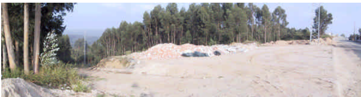
Foto 6 – Vista para sueste, junto à via paralela à EN 1 (para o seu lado nascente), que será cruzada em túnel pelas soluções 1 e 2 (e também pela alternativa 1). Para lá dos eucaliptos, à esquerda, surgirá um nó à saída do túnel (em qualquer destas soluções).
