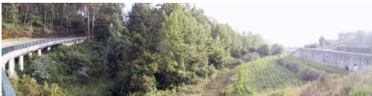
Foto 12 – Vista para poente, a partir da EM 513, de um viaduto sobre o Rio Antuã, a norte de Milheirós de Poiares. Vindas do vale, a solução 1, alternativa 1 e alternativa 2, juntam-se e percorrem a área florestal à esquerda. A alternativa 1 e a alternativa 2 terminam aqui, enquanto a solução 1 atravessa a EM 513.
