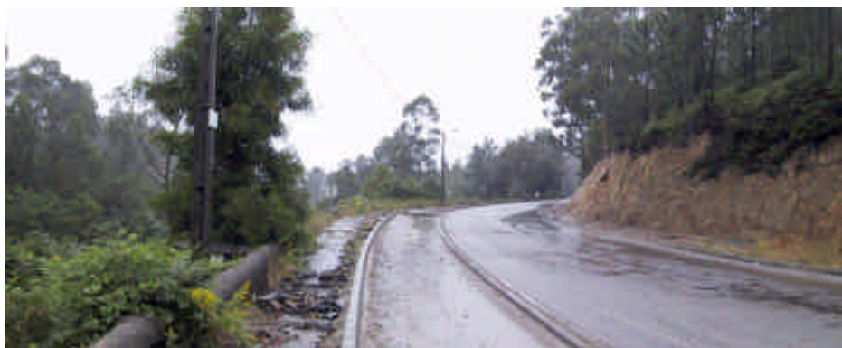
Foto 15 – Vista para sudoeste, a partir da EN 327 a ponte de Cesar e Cimo de Vila. Vinda do lado direito desta via, e depois de um nó, a solução 2 entra, à esquerda da mesma, em área florestal.
