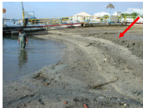
Fotografia 4.8.2 – Vista da área de estudo a partir de Este. Note-se a zona dragada
