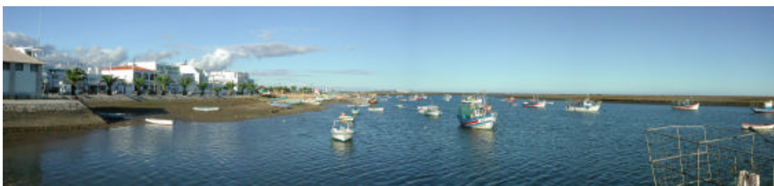
Fotografia 4.7.1 – Vista da unidade de paisagem “ área urbana ”, onde se observa o limite da malha urbana, a rua marginal e a área portuária de Santa Luzia, com grande densidade de embarcações estacionadas sobre uma zona que se encontra quase sempre seca e no canal (unidade de paisagem “ ria ”). Para Sul, observam-se predominantemente sapais que se encontram na unidade “ zona entre-marés ”
