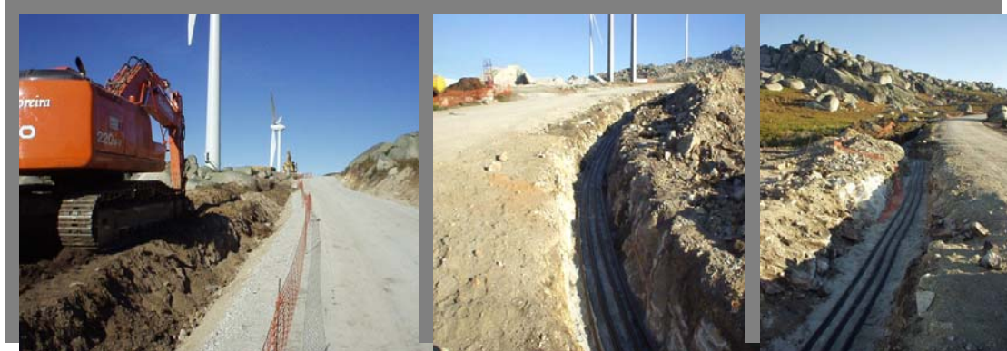
Figura 10 – Vala para instalação dos cabos eléctricos.
