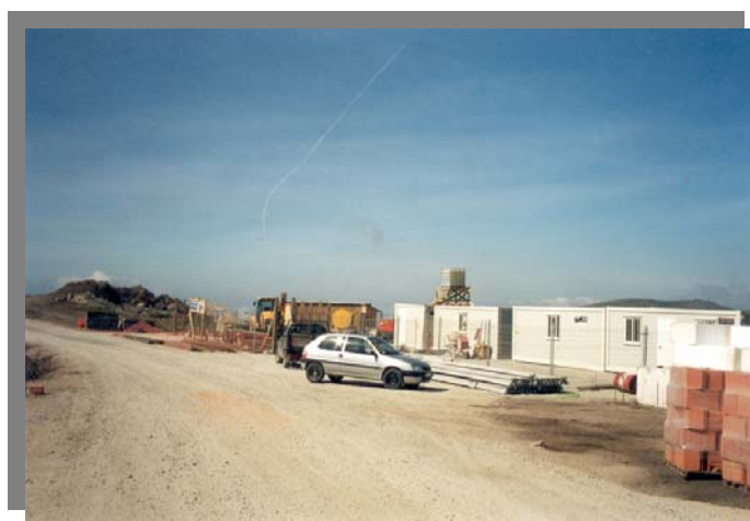
Figura 11– Estaleiro de uma obra semelhante
