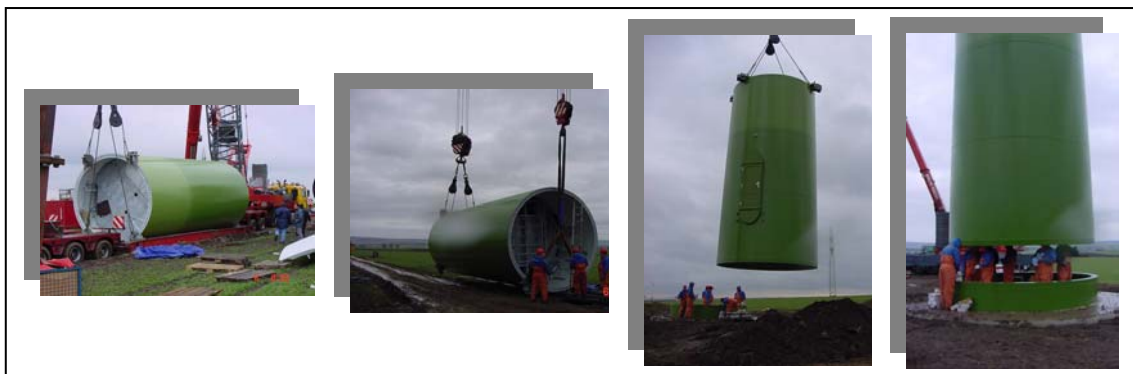
Figura 8– Montagem da torre de um aerogerador.
