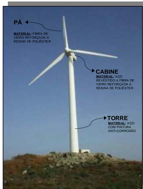
Figura 1 – Constituição principal de um aerogerador.
