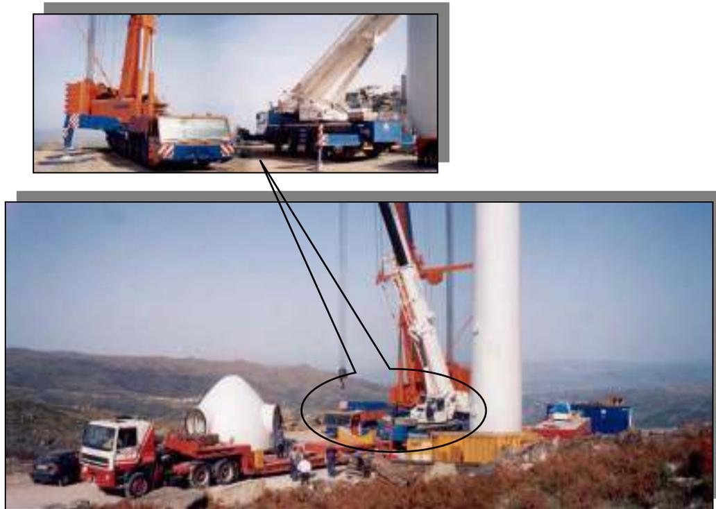
Figura 17 – Ocupação e dimensão necessária de uma plataforma para a montagem de aerogeradores de 2000 kW.
