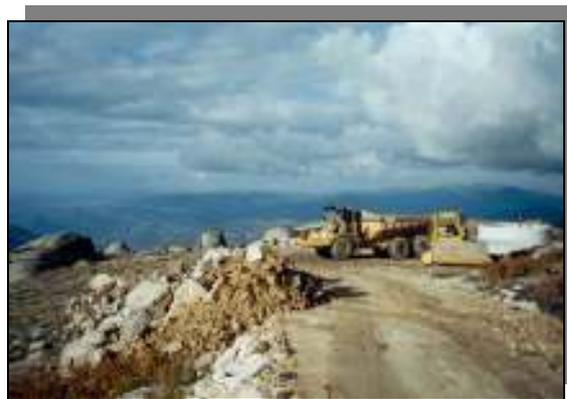
Figura 16 – Preparação da plataforma provisória para montagem dos aerogeradores.
