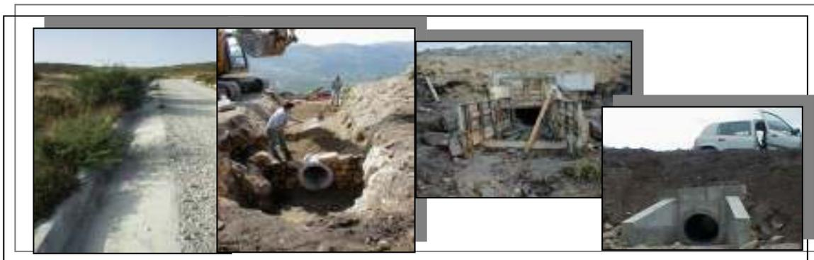
Figura 14 – Valeta e construção de uma passagem hidráulica.
