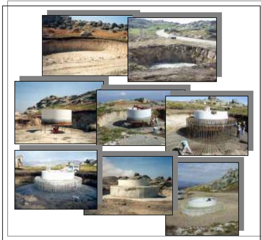
Figura 15 – Execução da fundação da torre de um aerogerador.
