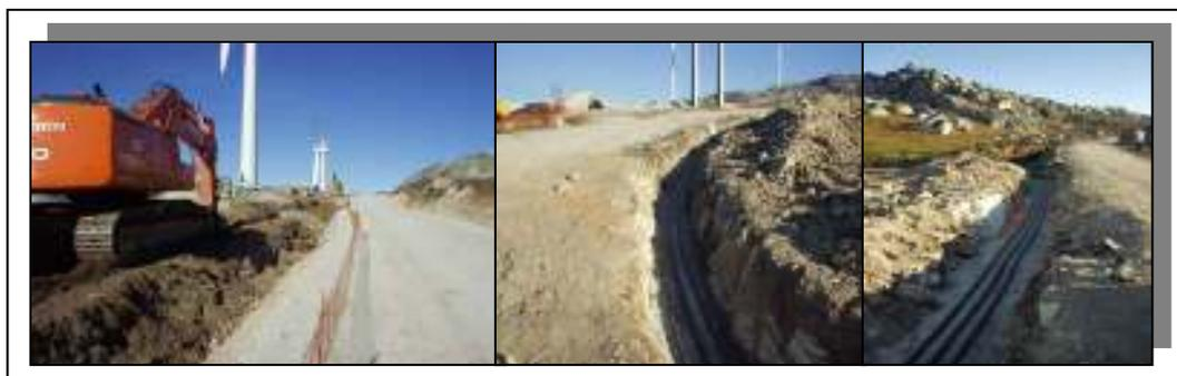
Figura 20 – Vala para instalação dos cabos eléctricos.
