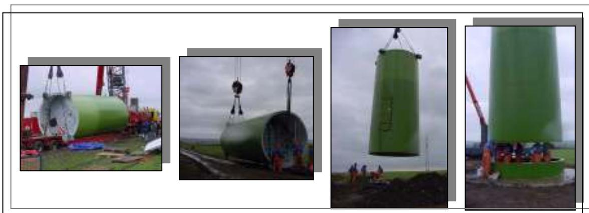
Figura 18 – Montagem da torre de um aerogerador.
