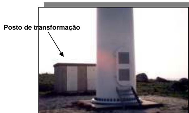
Figura 2 – Exemplo de um posto de transformação de um aerogerador num parque eólico.
