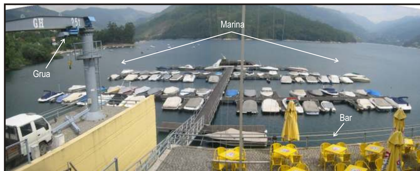
Foto 2 - Aspecto Geral da Estrutura Flutuante do Actual Centro Náutico
