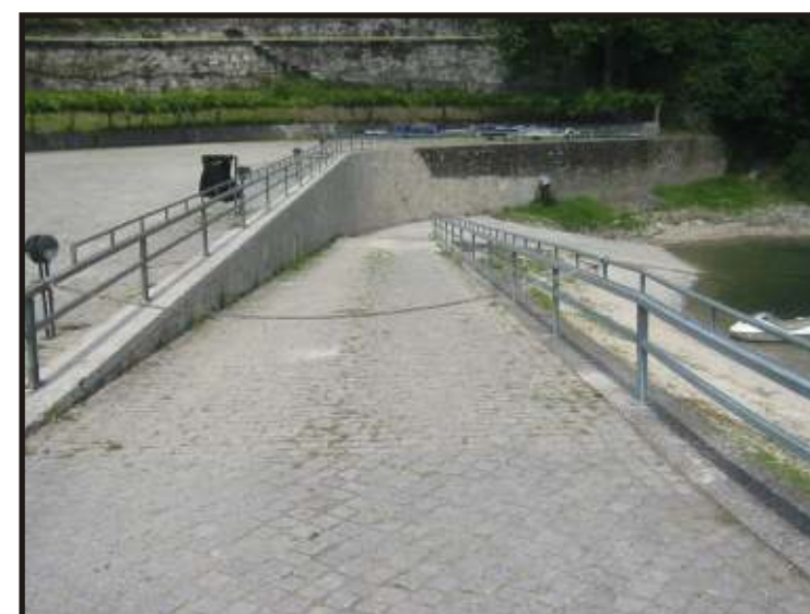
Foto 5 - Rampa de Varadouro
