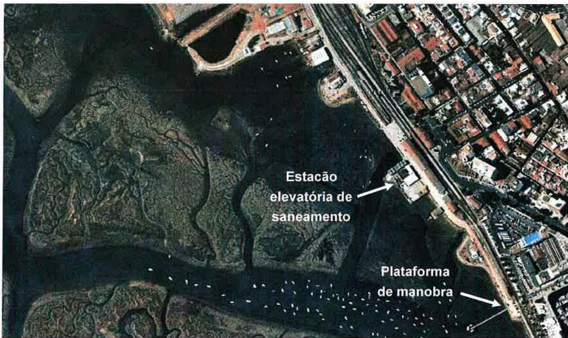
Fotografia 2.6 Possível acesso viário à plataforma de acesso à ponte cais.
