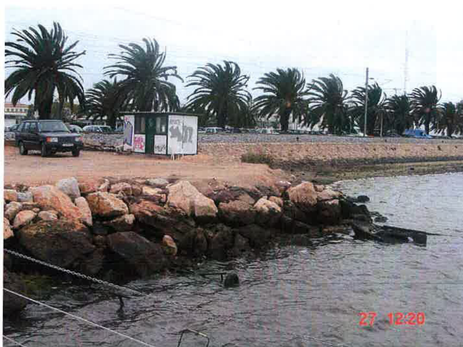
Fotografia 2.3 Enrocamento de retenção da margem da plataforma existente na zona do Fundeadouro A, vista para Sul.
