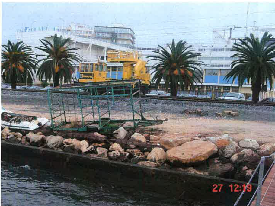
Fotografia 2.1 Enrocamento de retenção da margem da plataforma existente na zona do Fundeadouro A, vista para Norte.
