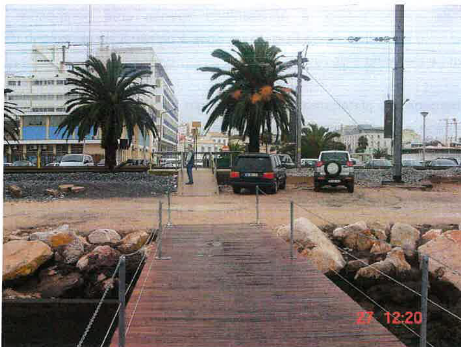
Fotografia 2.2 Plataforma de acesso à ponte cais, no local da alternativa A do Fundeadouro.
