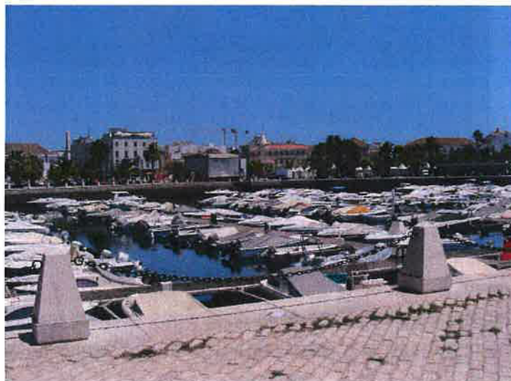
Fotografia 5.5 - Vista da actual doca, com excesso de ocupação.
