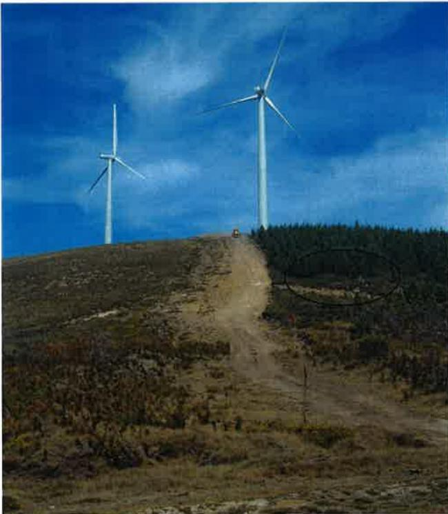
Foto 1 - Zona do aerogerador mais próximo do PE de Penedo Ruivo (em construção). Não será utilizado o troço do acesso existente entre estes devido ao elevado declive. Foi identificada uma ocorrência patrimonial (gravura) um pouco a Sul deste aerogerador que tem de ser preservada. Ponderou-se a não utilização desta localização, sendo indicado pelo proponente um local alternativo, mas que está fora da área de estudo.
