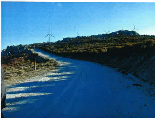
Foto 24 – Acesso e zona do aerogerador 4
