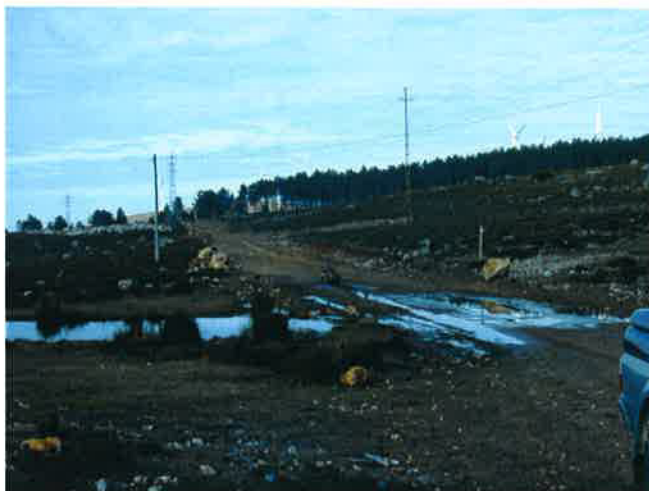
Foto 6 – Zona de estaleiro - é proposta a zona do lado esquerdo do acesso, mas atendendo à existência de uma zona húmida, será melhor utilizar o lado direito do acesso
