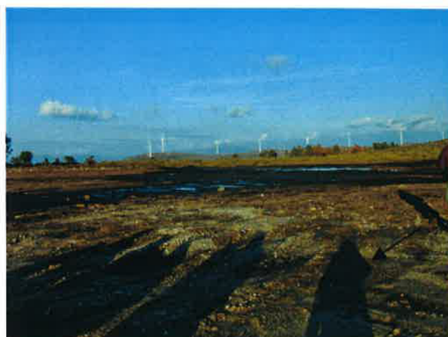
Foto 20 – Zona de estaleiro e subestação – esta zona já foi aproveitada como estaleiro do PE Candal
