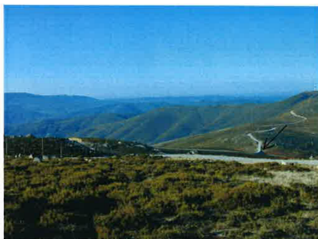
Foto 25 – Aerogeradores ao longo do acesso existente, ao fundo na zona do acesso com talude mais marcado fica a área do posto de seccionamento e do estaleiro
