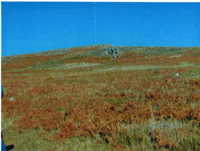
Foto 33 – Zona da subestação e do estaleiro
