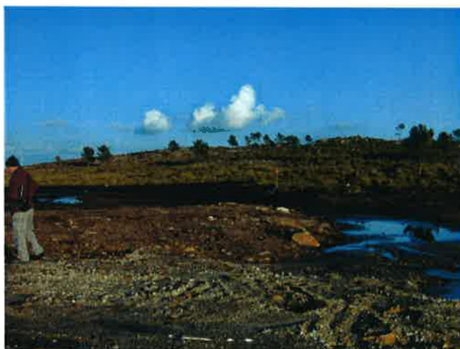
Foto 21 – Zona do aerogerador 14
