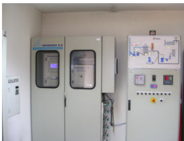
Figura 6 – Equipamento de medição em contínuo das emissões gasosas.
