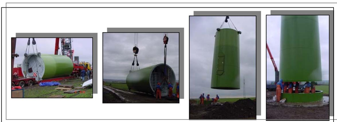
Figura 14 – Montagem da torre de um aerogerador.
