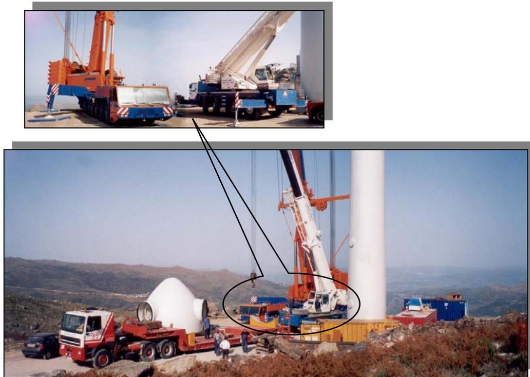
Figura 13 – Ocupação e dimensão necessária de uma plataforma para a montagem de aerogeradores de 2000 kW.
