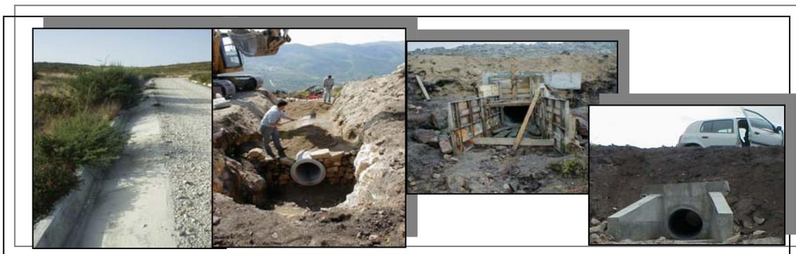
Figura 10 – Valeta e construção de uma passagem hidráulica.
