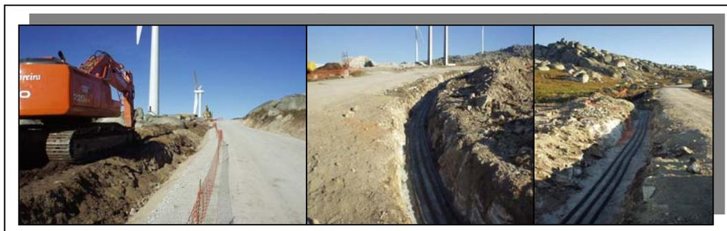
Figura 16 – Vala para instalação dos cabos eléctricos.
