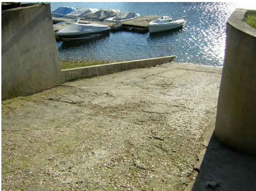
Trata-se de um acesso com largura de 4 metros, 80 metros de comprimento e piso de cimento com malha de ferro. O lançamento de embarcações ao plano de água só pode ser efectuado com veículo próprio e pessoal habilitado, ao serviço da marina.
