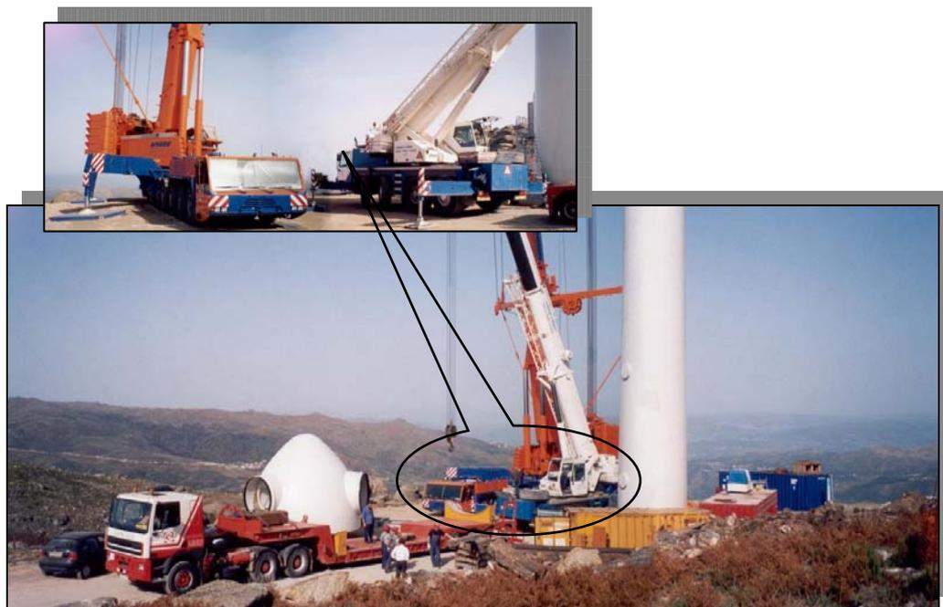
Figura 11 – Ocupação e dimensão necessária de uma plataforma para a montagem de aerogeradores de 2000 kW.
