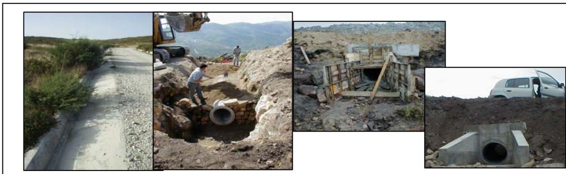
Figura 9 – Valeta e construção de uma passagem hidráulica.
