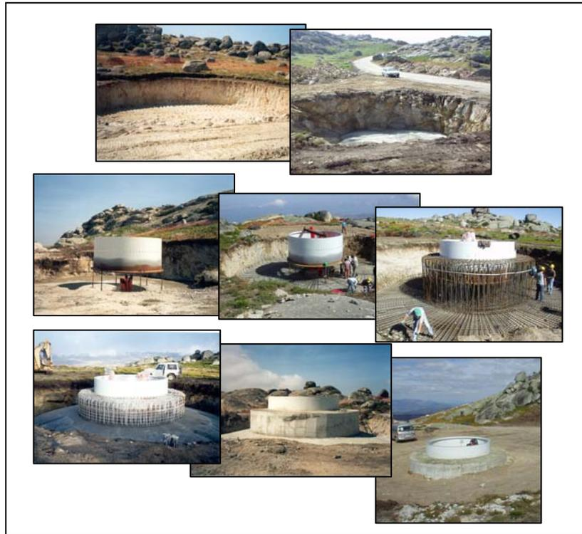
Figura 10 – Execução da fundação da torre de um aerogerador.
