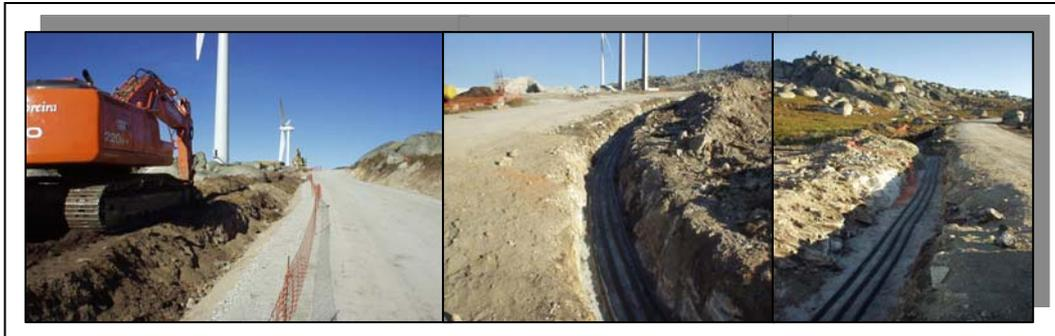
Figura 14 – Vala para instalação dos cabos eléctricos.
