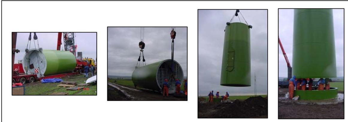
Figura 12 – Montagem da torre de um aerogerador.
