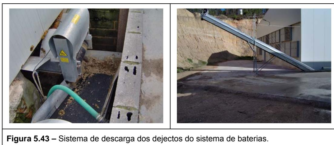
**Figura 5.43** – Sistema de descarga dos dejectos do sistema de baterias.
