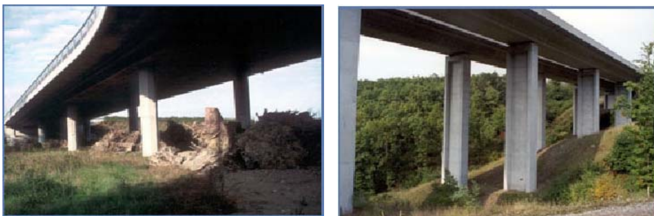
Figura 7.6.4 – Coberto de refúgio debaixo das zonas de ancoramento dos viadutos para refúgio e passagem de pequenos animais
