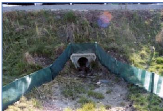
Figura 7.6.2 – Canal e cerca de malha fina para condução de pequenos animais à Passagem Hidráulica
