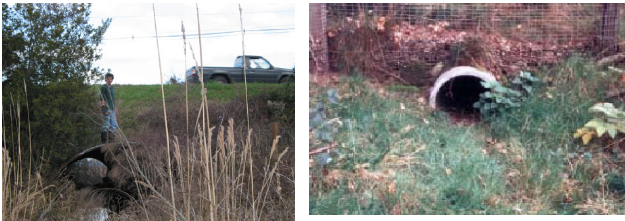
Figura 7.6.3 – Coberturas vegetais na entrada de Passagens Hidráulicas
