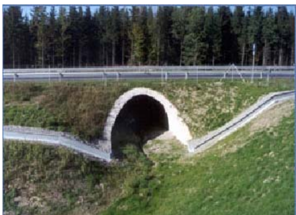
Figura 7.6.2 – Canal e cerca de malha fina para condução de pequenos animais à Passagem Hidráulica
