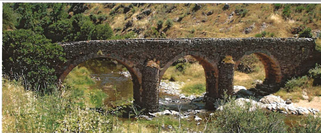
Figura 1 – Vista jusante da ponte
