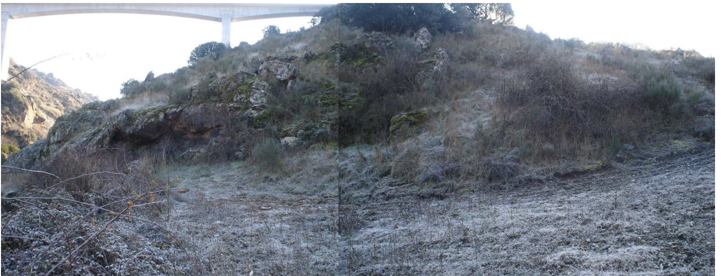
Vista para a zona de saída da conduta em túnel e onde passará a conduta forçada que irá ter à central
