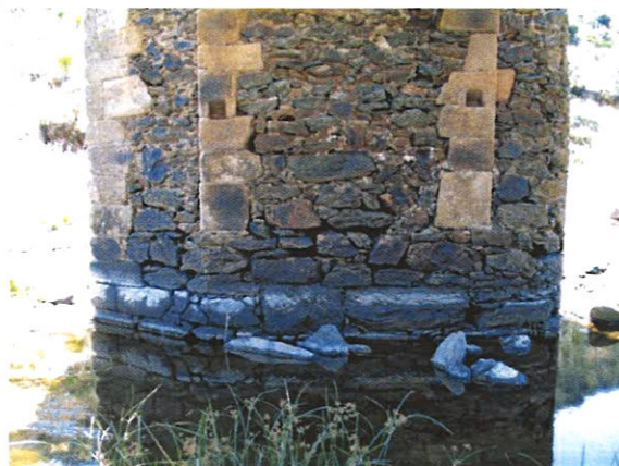
Figura 9 – Fundação em pedra de xisto e granito
