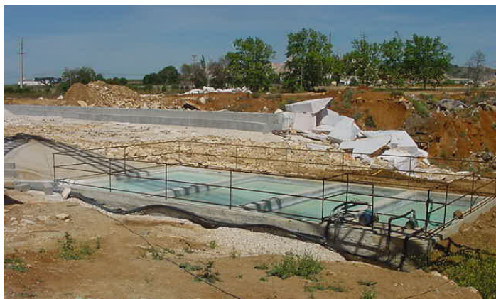
Figura 9. Tanque de decantação (em construção) onde será realizado o tratamento das águas.
