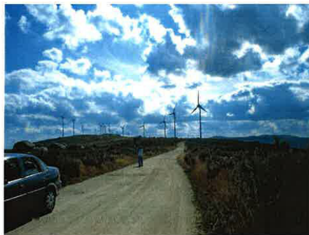
Acesso do aerogerador 1 para o Parque Eólico de Vila Lobos
