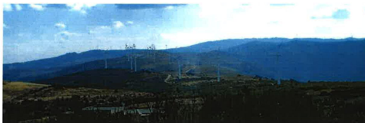
Vista do aerogerador 5 para os outros parques eólicos (Parque Eólico de Fonte da Mesa, Parque Eólico de Vila Lobos e Parque Eólico de Bigorne)
