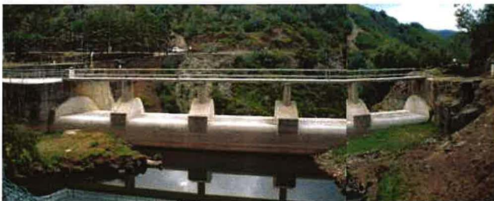
Vista do parque das merendas para o descarregador de cheias da barragem existente (que não vai ser demolido)
