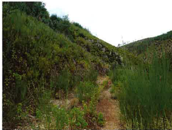
Margem esquerda, onde será construído o acesso à CM 1401
