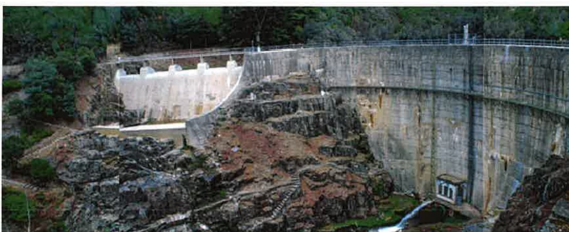
Vista da margem esquerda para a barragem existente
