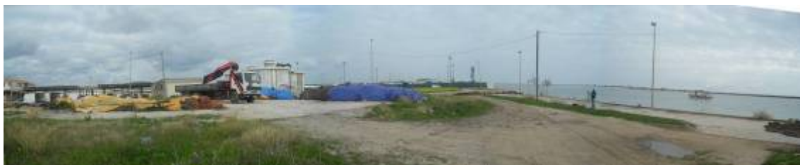
Fotografia 1 – Enquadramento geral da área de intervenção do projecto (lado Nascente)
