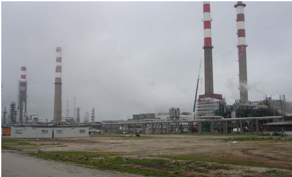
Vista Geral do Local de Implantação das Novas Unidades na Zona da Fábrica de Combustíveis (Destilação de Vácuo e Visbreaker )
