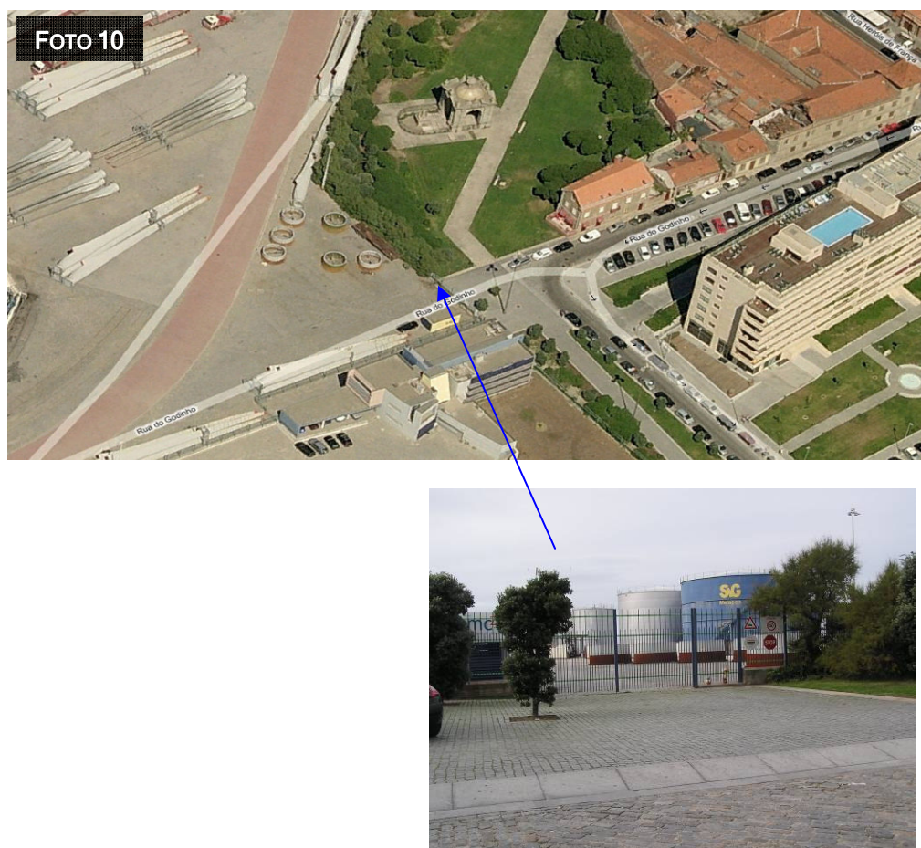
Foto 10 – Zona de entrada no Molhe Sul. Pormenor do Portão de Entrada.
