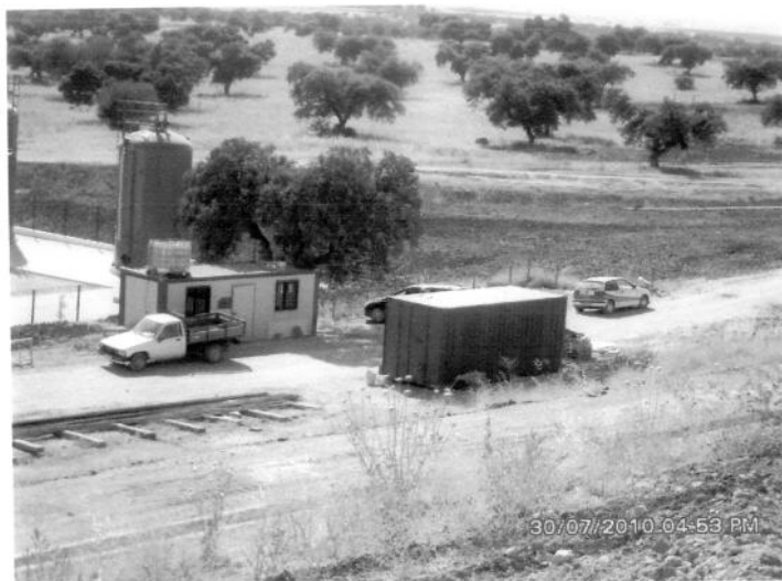
Fig. 1 – Estaleiro de apoio de Reservatório de Brinches Sul
