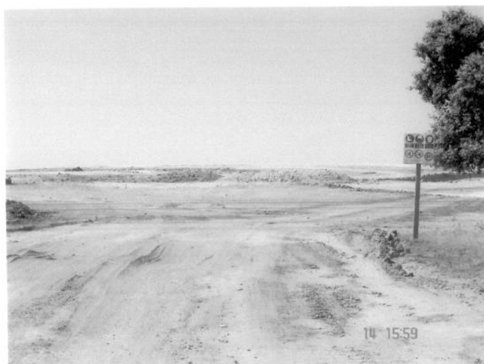
Fig. 7 – Sinalização de entrada do estaleiro do Reservatório de Brinches Sul
