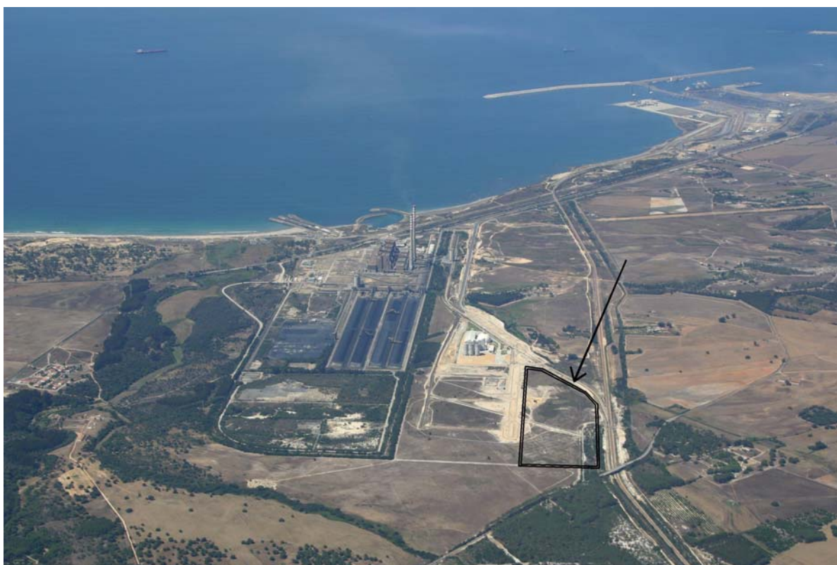
Fotografia 1 Vista Aérea da Localização Prevista para a CCCS
