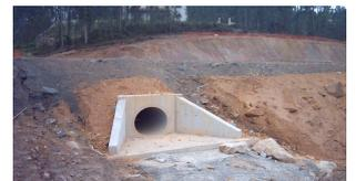
Exemplo de uma passagem hidráulica
