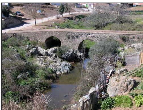
Foto 1.20 - Fotografia geral da Ponte de Selmes (R01).
