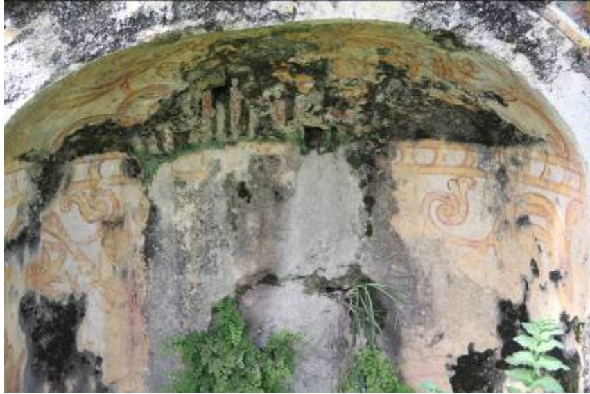
Figura 26 – Vestígios de pintura no muro
