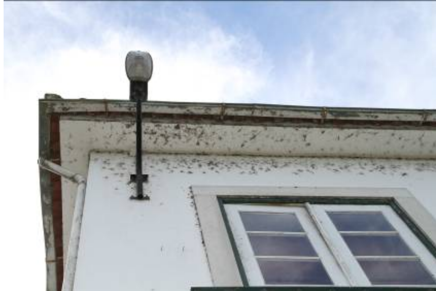
Figura 11 – Mau estado das caleiras que rodeia a cobertura do edifício
