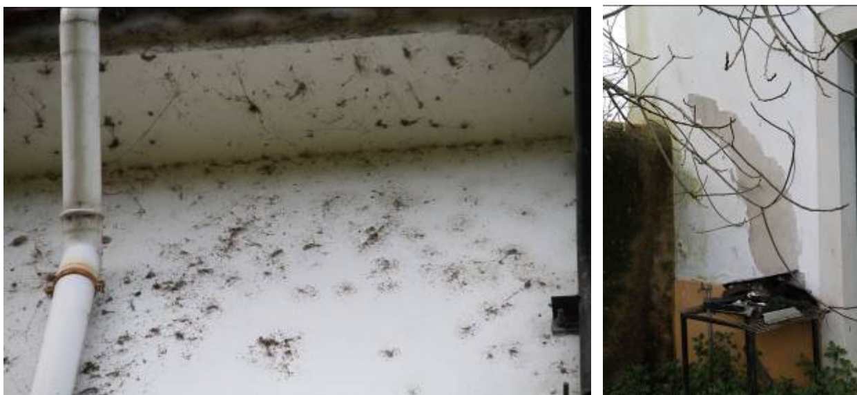
Figura 14 – Problemas de conservação dos edifícios da Figura 13
