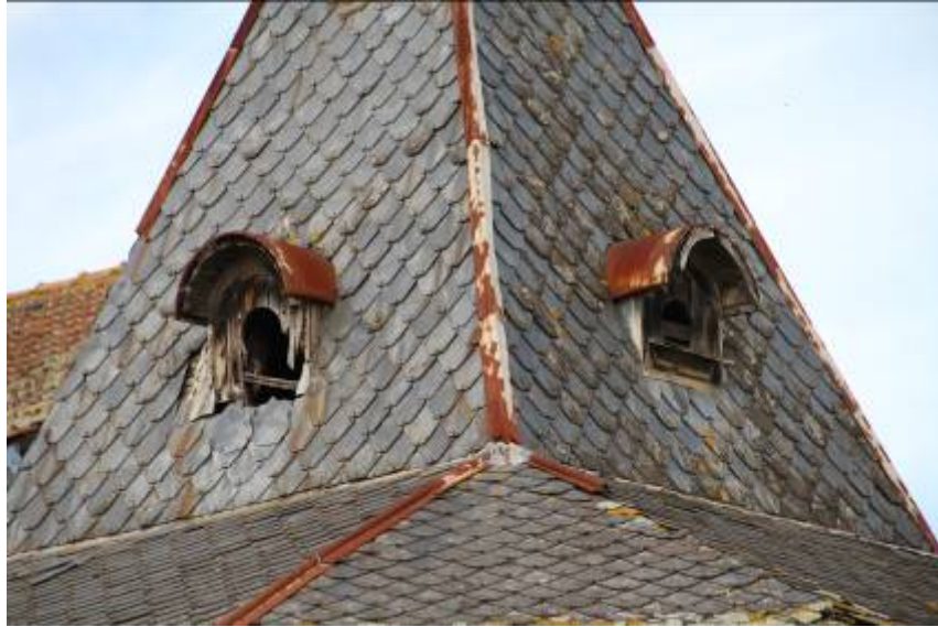
Figura 34 – Estado da cobertura do Chalet da figura 33
