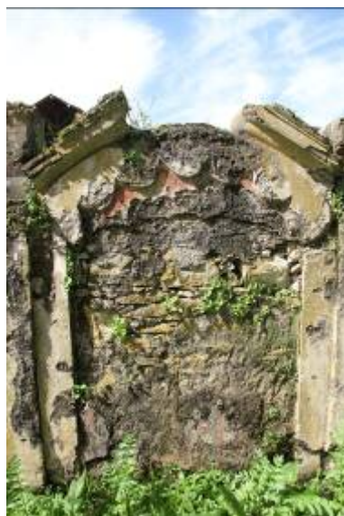
Figura 30 - Vista do muro
