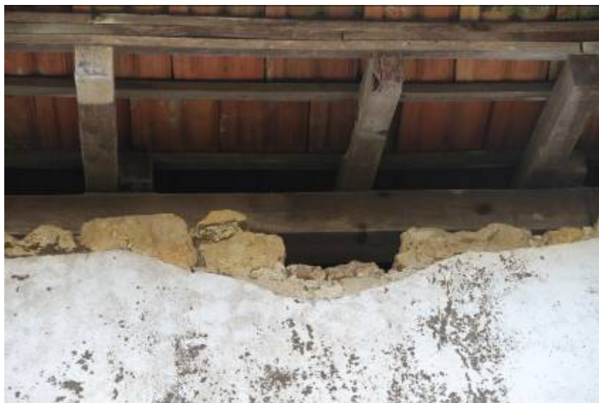
Figura 6 – Edifício mais a Norte – fissuras e danos no revestimento exterior
