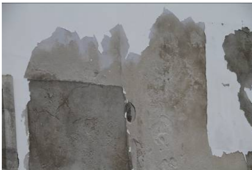
Figura 10 – Infiltrações do corpo principal do edifício
