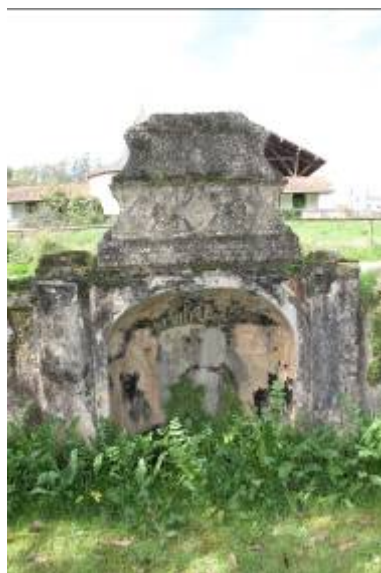
Figura 25 – Vista de um dos nichos de muro
