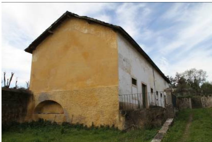
Figura 3 – Edifício Situado mais a Sul
