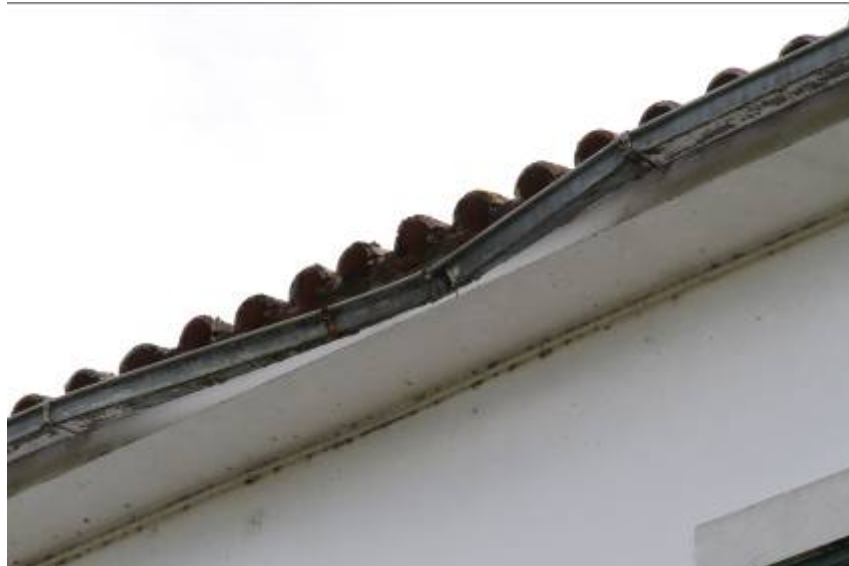
Figura 12 – Caleiras em mau estado de conservação
