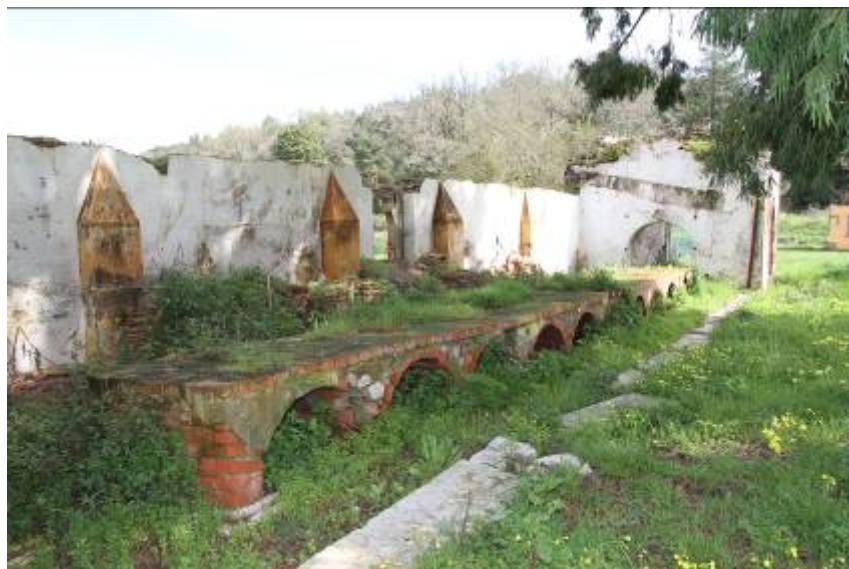
Figura 21 - Construção a Norte, que incluem fontes, em ruínas
