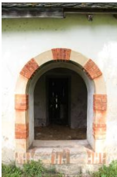
Figura 22 - Construção a Norte, que incluem fontes, em ruínas
