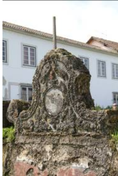
Figura 28 – Vista do muro
