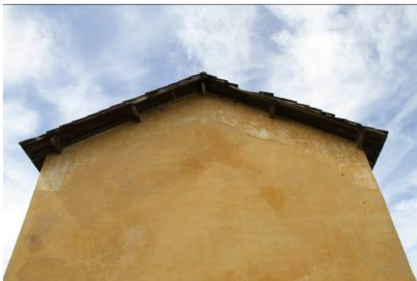
Figura 5 – Alçamento do edifício mais a Sul
