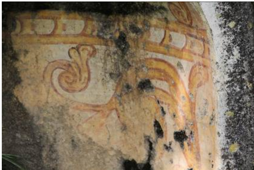
Figura 27 - Vestígios de pintura no muro
