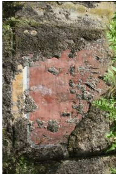
Figura 29 - Vista do muro
