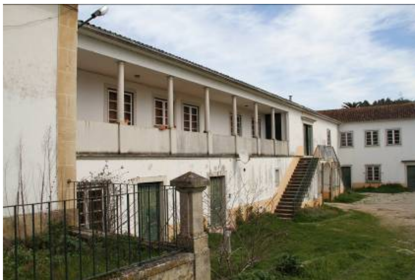
Figura 9 – Corpo principal do edifício – varanda de colunas e escadaria de acesso ao piso superior
