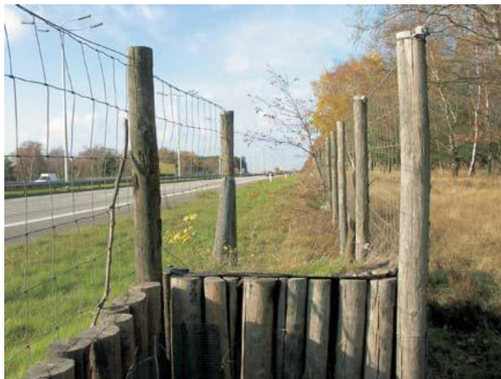
Figura 5.1 – Rampa de escapatória (Fonte: Ministerio de Medio Ambiente. 2006).
