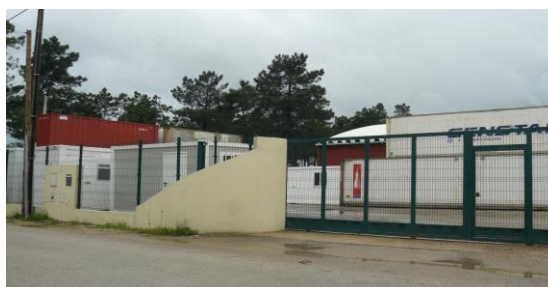
Figura 5.11– Armazém de contentores
