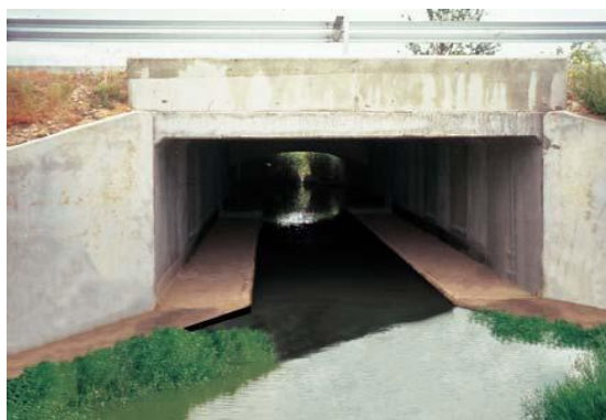
Figura 5.7 – Passagem hidráulica com plataformas laterais secas (Fonte: Ministerio de Medio Ambiente, 2006).
