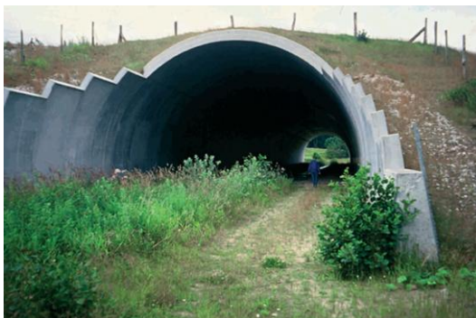
Figura 5.5 – Passagem inferior adaptada com corredor de vegetação herbácea (Fonte: Iuell et al. , 2003).
