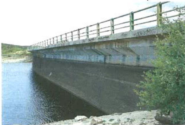
FIGURA VII.2 – Montante da Barragem. Nível de armazenamento à cota 1.248m. (10-09-2011)
