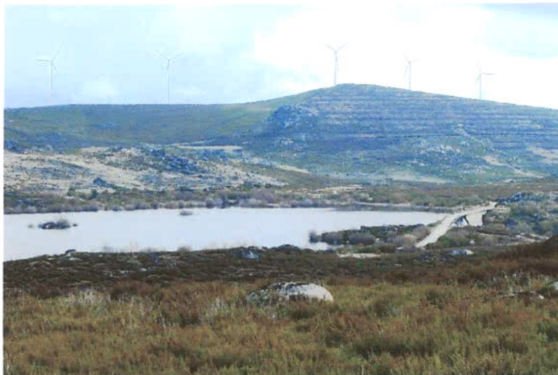
VISTA DA BARRAGEM ACTUAL, NO NÍVEL DE PLENO DE ARMAZENAMENTO (03-04-2011)
