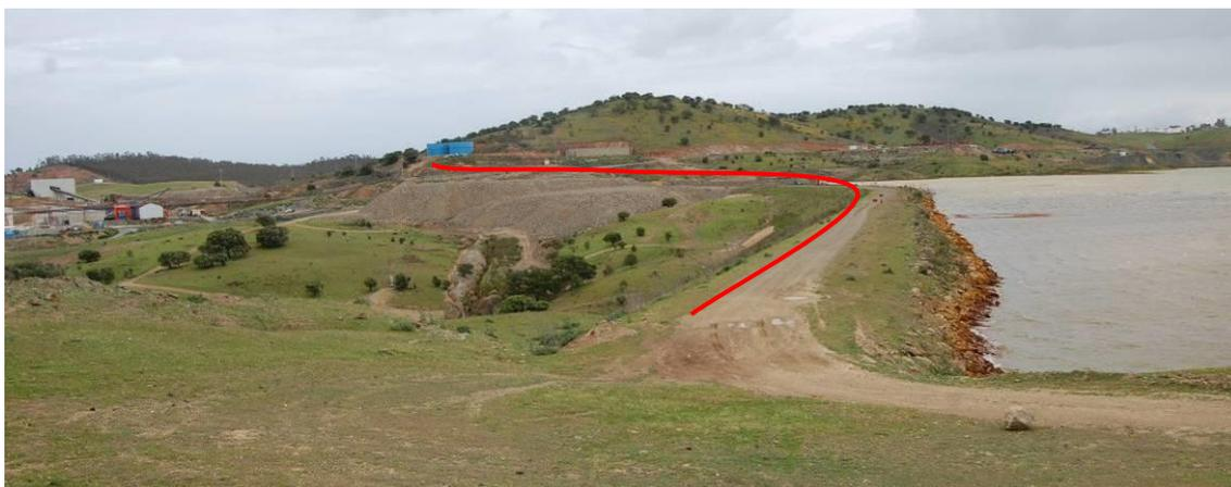
**Figura 107 – Localização do Alçamento da Barragem de Rejeitados sobre a barragem existente.**
