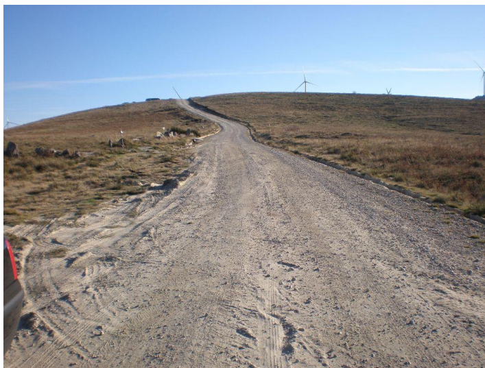
Foto 1 – Acesso principal ao Sobreequipamento, vista do local previsto para a subestação para Este
