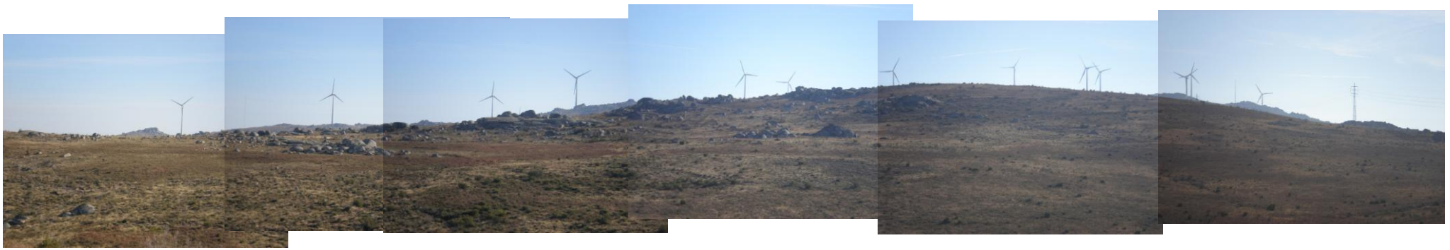
Fotos 6 a 11 – Cumeada prevista para a implantação dos aerogeradores 2 e 4, e respetivo acesso, vista de zona a Oeste
