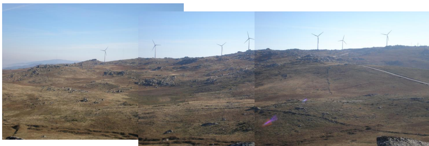
Fotos 17 a 19 – Zona prevista para a implantação dos aerogeradores 7 a 11 e respetivos acessos, vista de zona a Oeste
