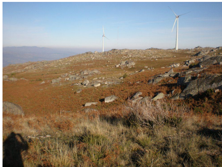
Foto 31 – Zona do acesso alternativo ao local previsto para a implantação do aerogerador 9 (ligação ao Parque Eólico de Fonte da Quelha), vista do local do aerogerador 10
