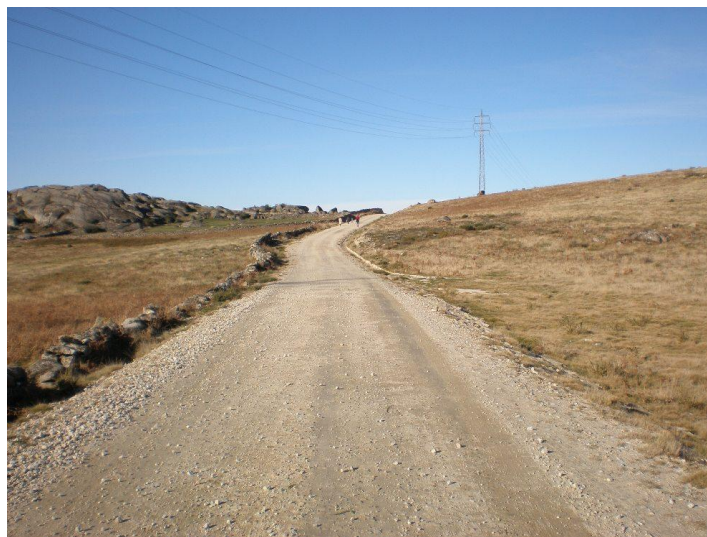
Foto 2 – Acesso principal ao Sobreequipamento, vista do local previsto para a subestação para Oeste
