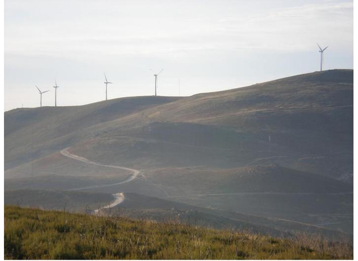
Foto 2 – Traçado previsto para a implantação da rede de cabos entre o aerogerador e a subestação do Parque Eólico de S. Pedro; Cabeço em que a vala se desvia do acesso
