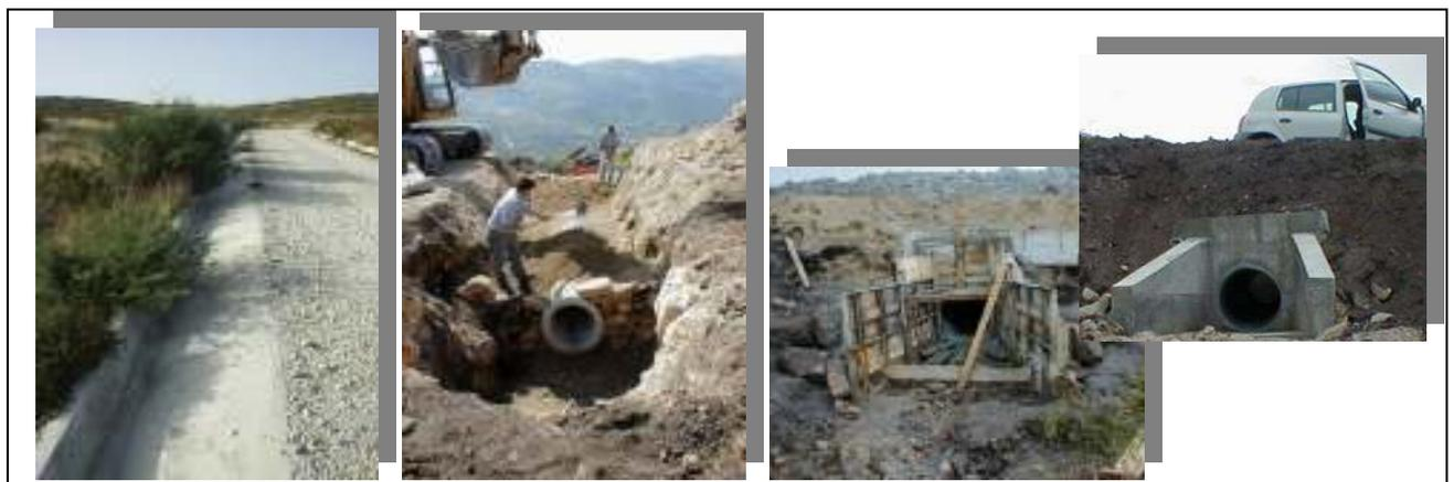
Figura 4 – Valeta e construção de uma passagem hidráulica.
