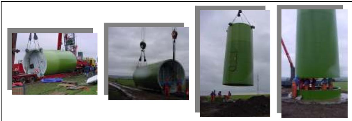
Figura 7 – Montagem de uma torre em aço.
