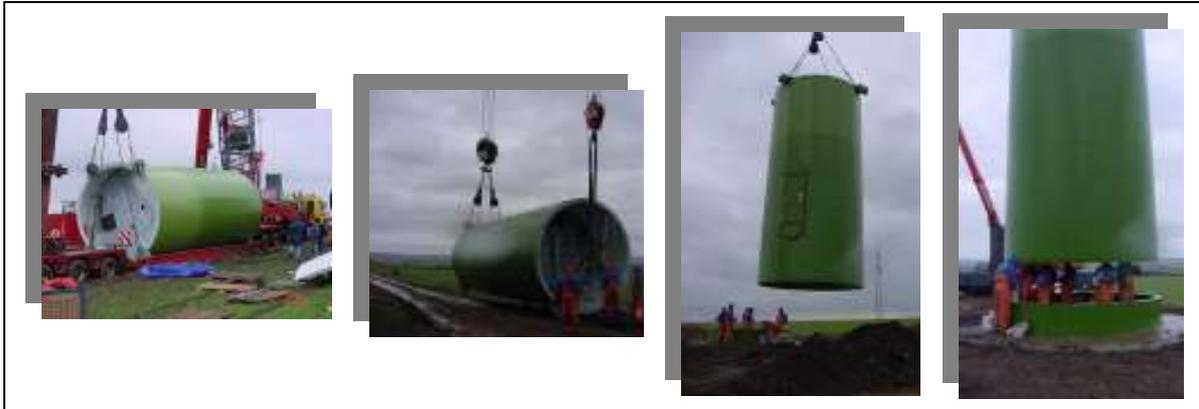
Figura 7 – Montagem de uma torre em aço.
