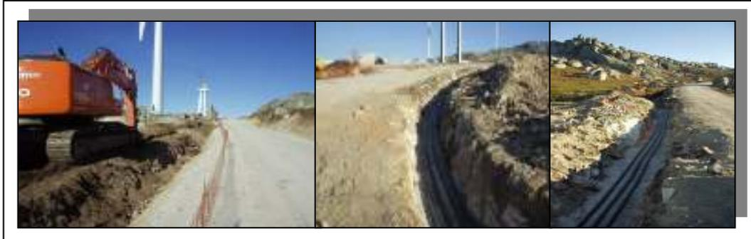
Figura 9 – Vala para instalação subterrânea dos cabos eléctricos e de comunicações.
