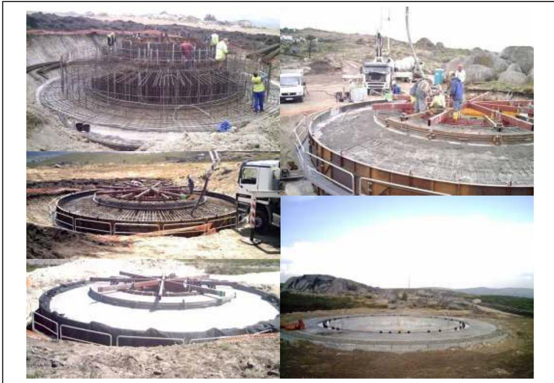
Figura 5 – Execução da fundação da torre de um aerogerador.
