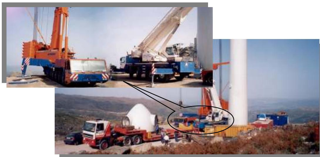
Figura 6 – Ocupação e dimensão de uma plataforma de trabalho para montagem de um aerogerador.
