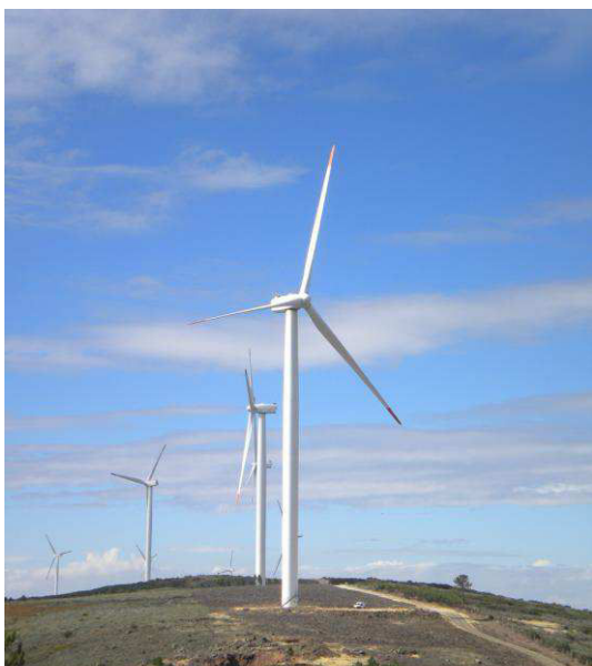
Foto 5 – Acesso ao local previsto para o aerogerador 19, vista da zona do aerogerador para o Parque Eólico do Sabugal (aerogeradores 12, 11 e 10)
