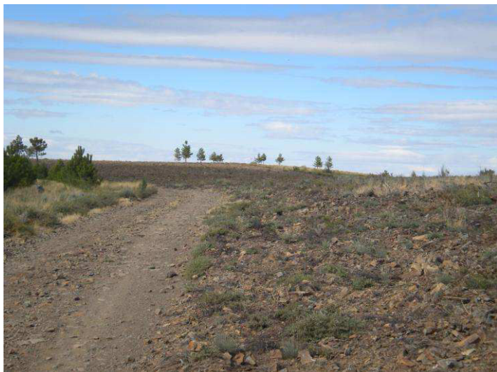
Foto 7 – Acesso entre os locais dos aerogeradores 20 e 19
