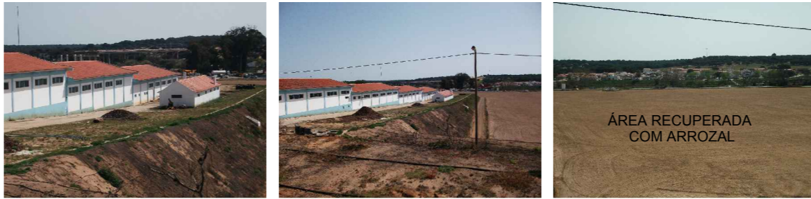
P2 - VISTA DE CRISTA DE TALUDE DA ÁREA A EXPLORAR PARA ESTE
