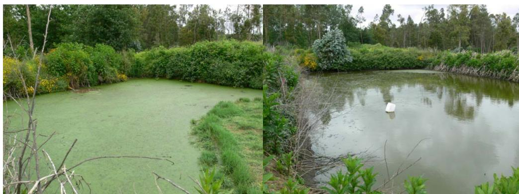
**Fotografia 4.14 – Tratamento final do efluente produzido pelo matadouro CARNES LANDEIRO (lagoas de armazenamento – 1ª lagoa à esquerda e última lagoa à direita)**
