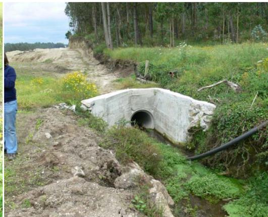
Fotografia 4.2 – Local de transição do barranco em superfície livre para conduta junto ao limite sul da propriedade (setor SE).
