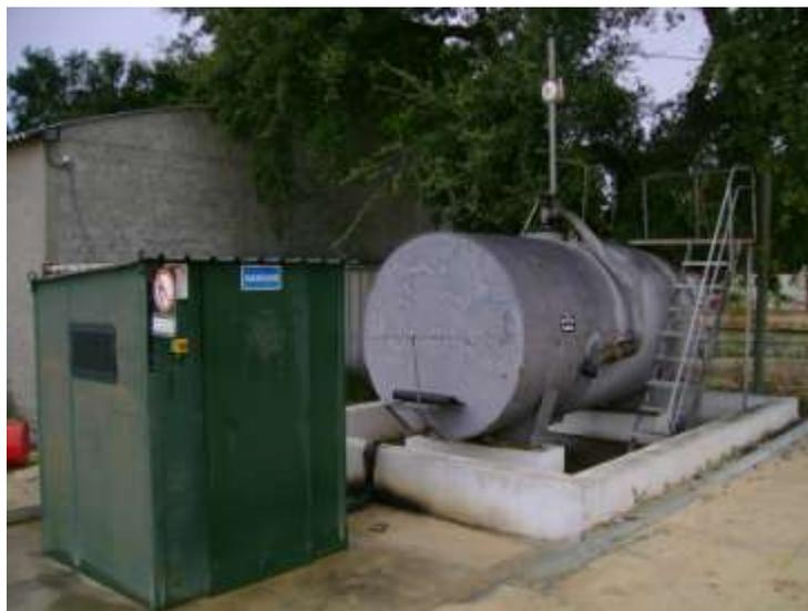
Figura II.17 – Posto de abastecimento e depósito de combustível.
