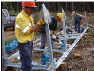
Montagem de um apoio
