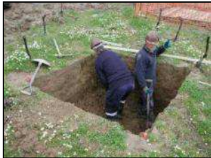
Trabalhos de escavação dos caboucos
