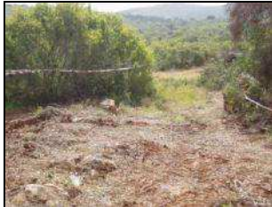
Trabalhos de sinalização dos apoios
