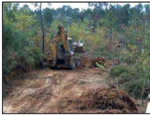
Trabalhos de desmatamento
