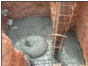
Betonagem do cabouco
