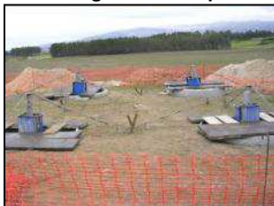
Vista após Betonagem
