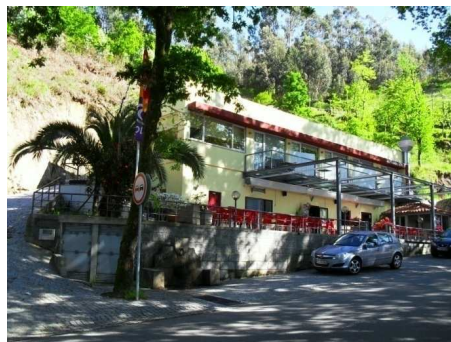
Restaurante localizado à beira da estrada e na proximidade da linha
