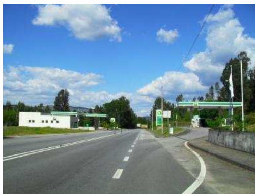
Posto de Abastecimento
