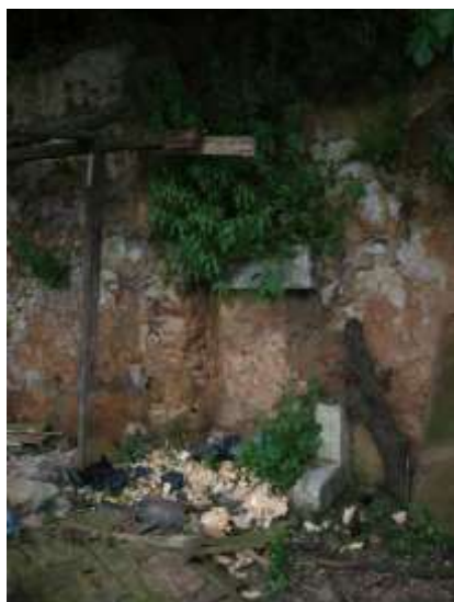
Figura 4.98 e Figura 4.99 - Edifícios em ruína de aparelho de alvenaria e reboco de pedra e cal.
