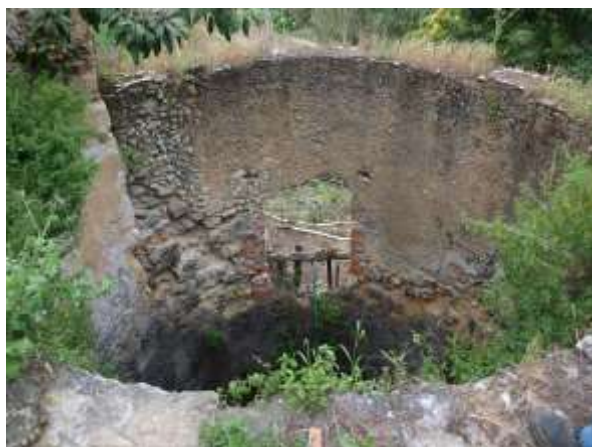
Figura 4.100 e Figura 4.101 - Edifícios em ruína de aparelho de alvenaria e reboco de pedra e cal.
