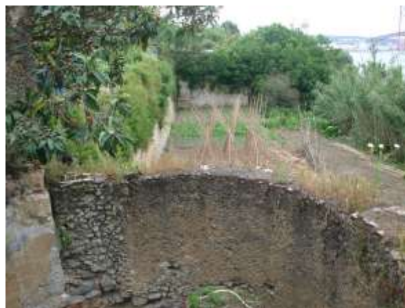
Figura 4.100 e Figura 4.101 - Edifícios em ruína de aparelho de alvenaria e reboco de pedra e cal.
