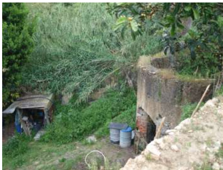
Figura 4.98 e Figura 4.99 - Edifícios em ruína de aparelho de alvenaria e reboco de pedra e cal.
