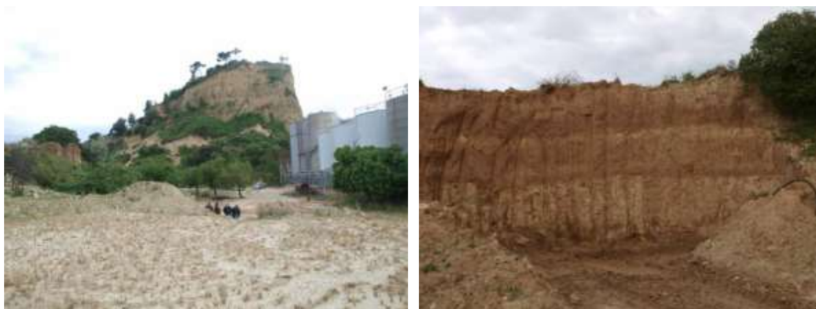
Figura 4.93 e Figura 4.94 - Condições boas de visibilidade (esquerda) e talude existente no local, após antiga movimentação de terras (direita).
