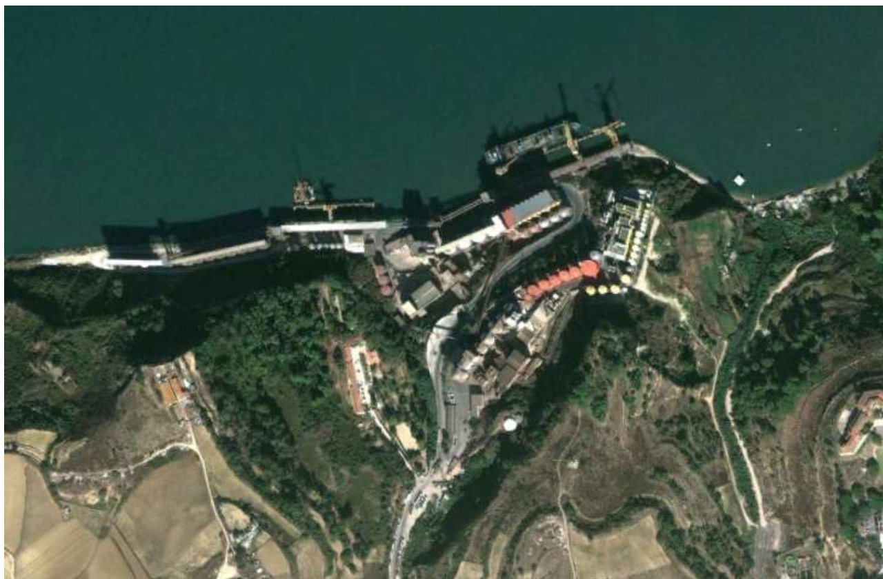
Figura 4.71 - Terminal de Graneis Alimentares de Palença 18
