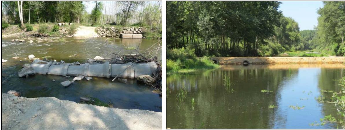
**FIG. 6 – Vista do Açude Temporário em terra e das Manilhas Existentes**
