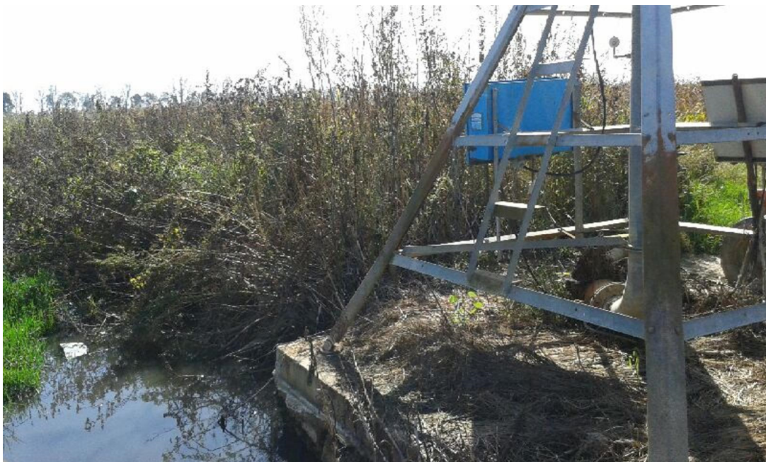
Fotografia 1 – Captação de água superficial desativada
