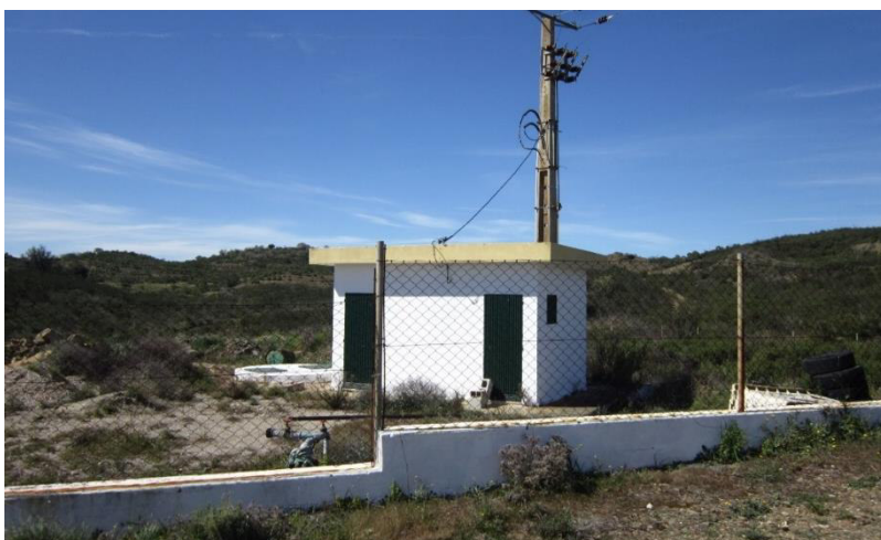
Fotografia 5.30 – Captação Pública Subterrânea de Martin Longo (RCM n.º 153/2003, de 26 de setembro)
