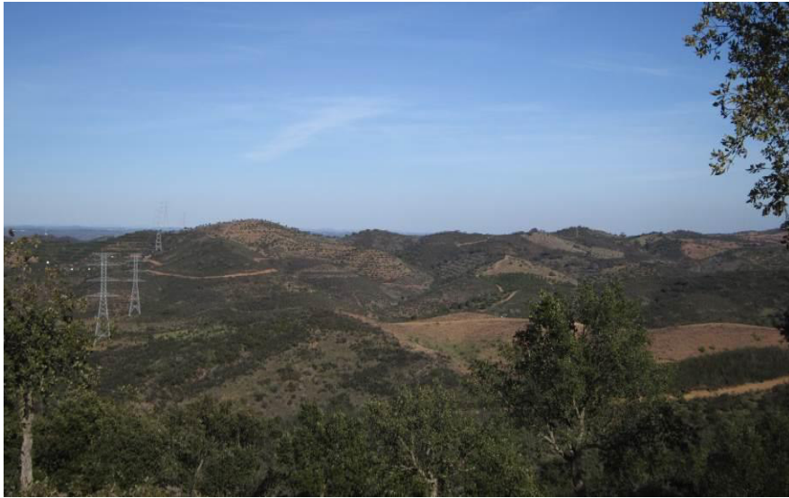
Fotografia 5.53 – Vista do Corredor da Linha Elétrica na direção à subestação a construir (a acompanhar uma linha já existente)
