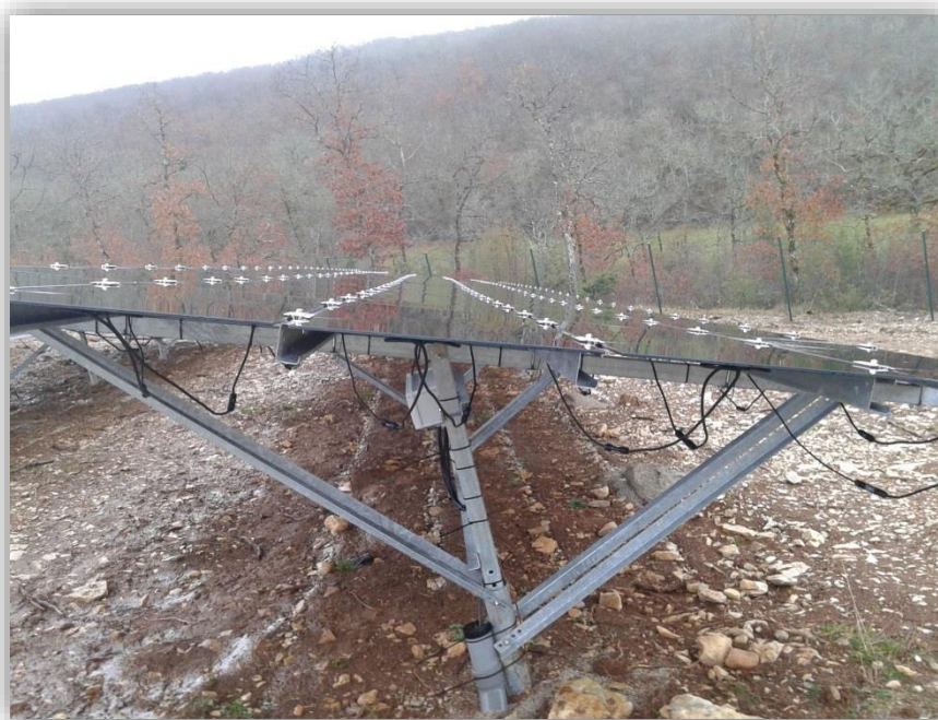
Fotografia 4.4 – Estrutura de suporte aos módulos fotovoltaicos
