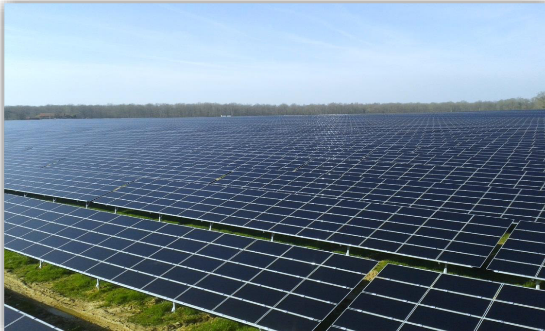
Fotografia 4.2 – Exemplo de pormenor de módulos fotovoltaicos
