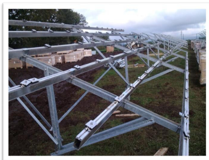
Fotografia 4.9 – Exemplo de montagem da estrutura de suporte dos módulos FV
