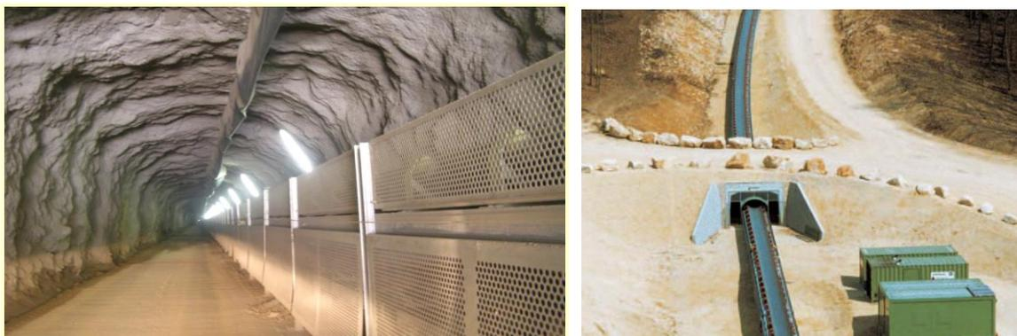
Figura II.43 – Imagem exemplificativa de um túnel de circulação mista (esquerda) e de um túnel para instalação de correia transportadora (direita).
