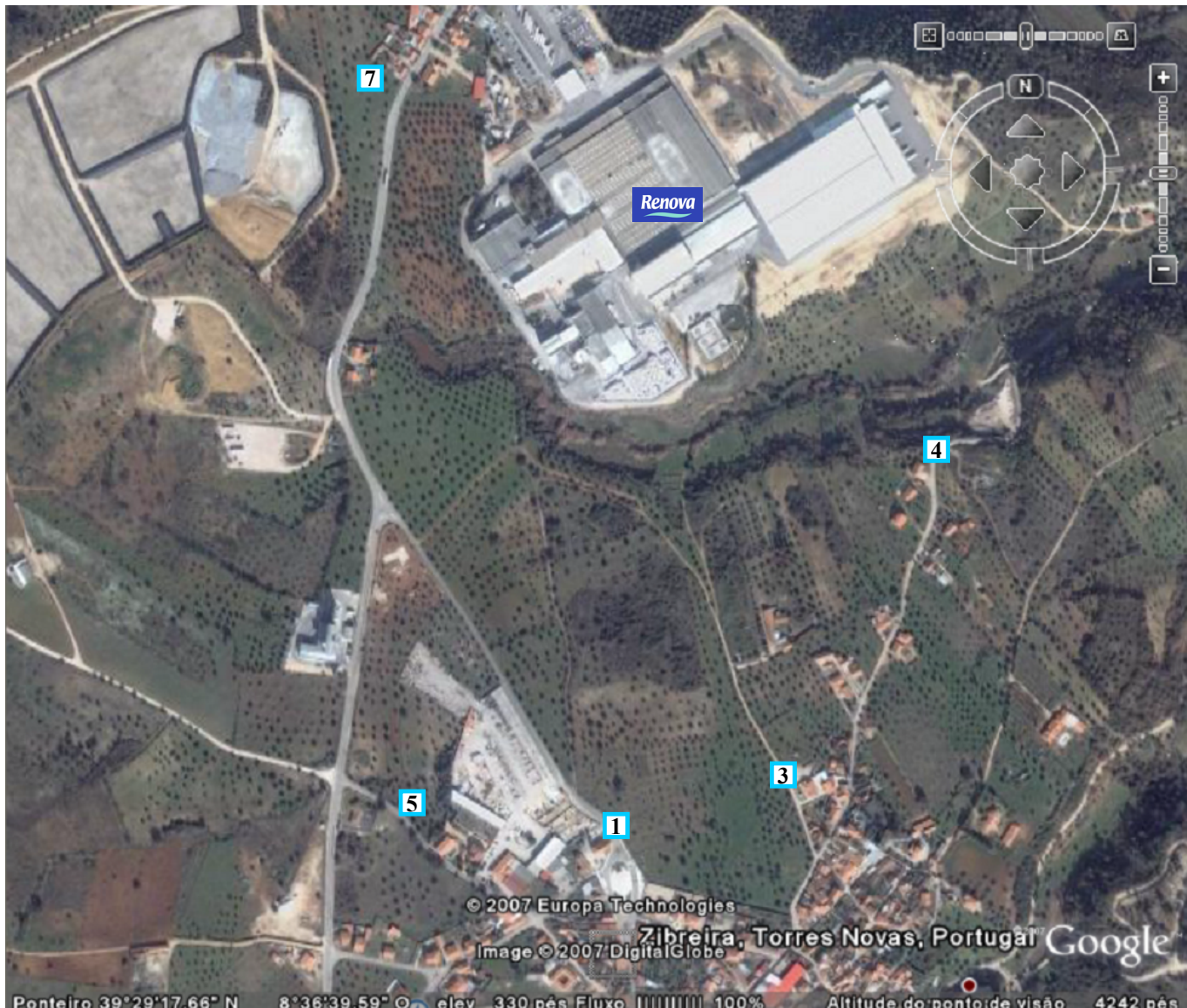
RENOVA - Fábrica de Papel do Almonda, S.A. (Fábrica 2)
