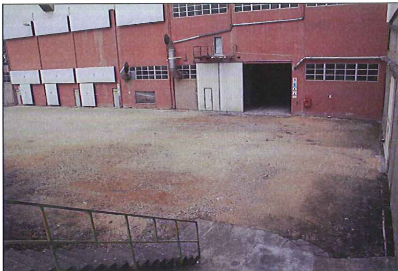
Foto 12 - Zona 4. Nova Unidade de Transformação de Papel (zona desaterrada e parcialmente impermeabilizada)
