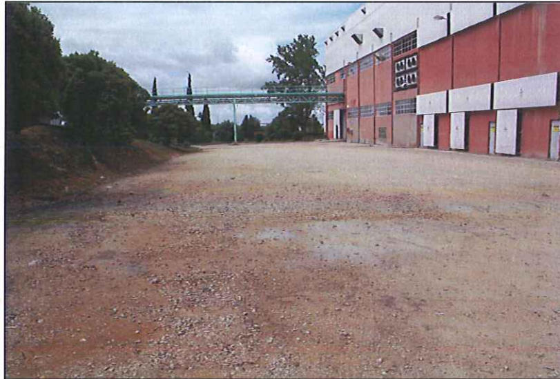
Foto 13 - Zona 4. Nova Unidade de Transformação de Papel. Outra vista (zona desaterrada e parcialmente impermeabilizada)
