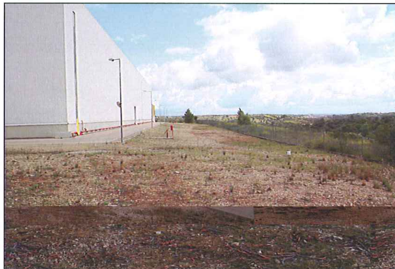
Foto 2 – Zona 1. Expansão do Armazém Produto Final. Outra vista
