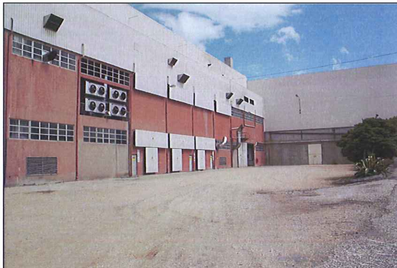
Foto 14 - Zona 4. Nova Unidade de Transformação de Papel. Outra vista (zona desaterrada e parcialmente impermeabilizada)
