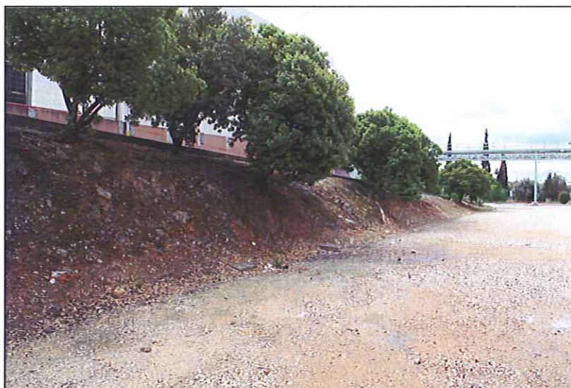
Foto 15 - Zona 4. Nova Unidade de Transformação de Papel (talude)
