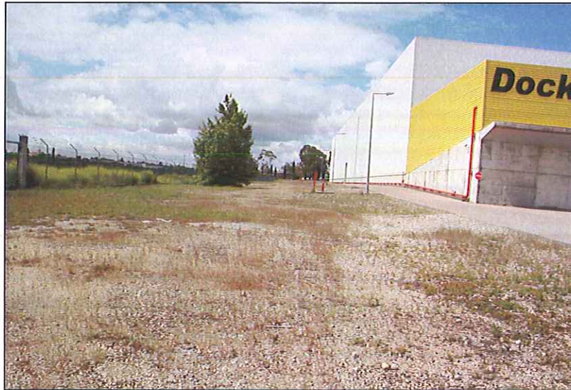
Foto 1 – Zona 1. Expansão do Armazém Produto Final (zona de aterro e terrapleno)
