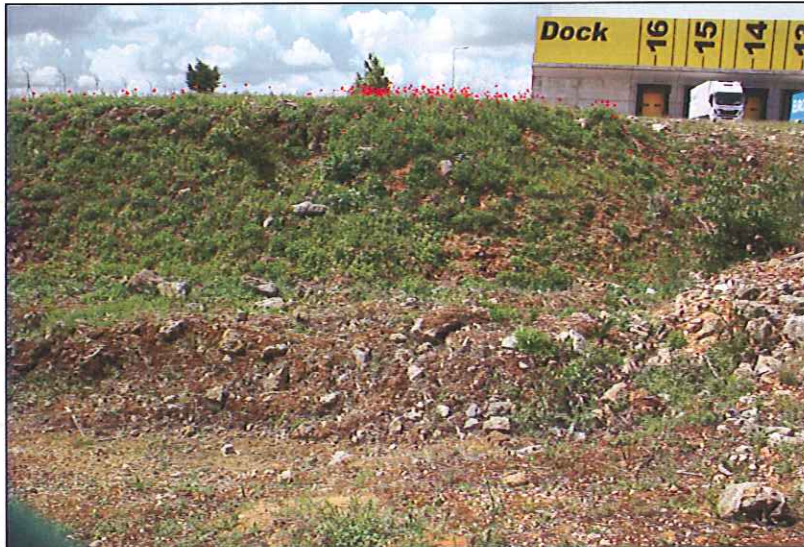
Foto 4 - Zona 1. Expansão do Armazém Produto Final (pormenor do aterro)
