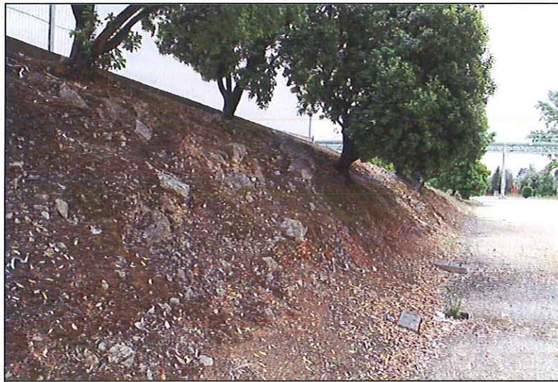
Foto 16 - Zona 4. Nova Unidade de Transformação de Papel (pormenor do talude)
