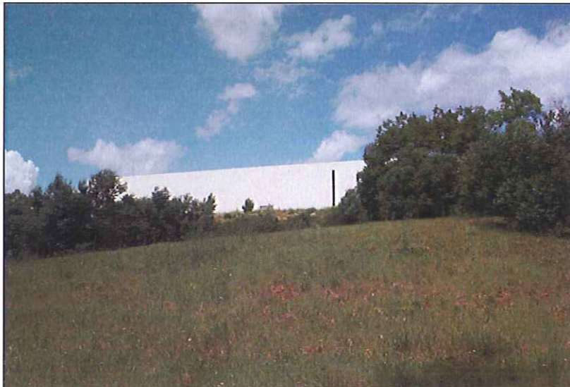
Foto 20 – Zona 6. Zona de terreno natural (em fundo aterro da zona 1)
