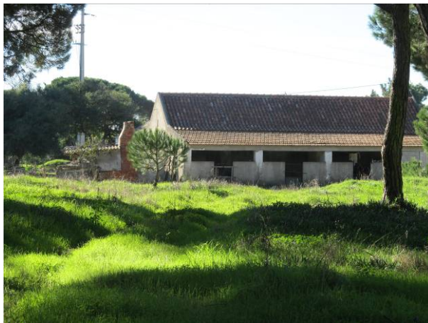
Fotografia 7 – Aspecto das construções existentes na área de incidência do projecto.
