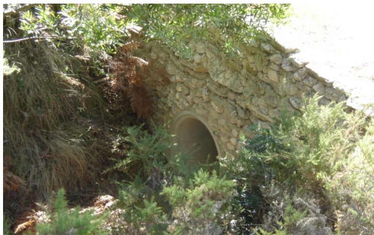
Figura 4.5.6 – Passagem hidráulica – limite noroeste da parcela
