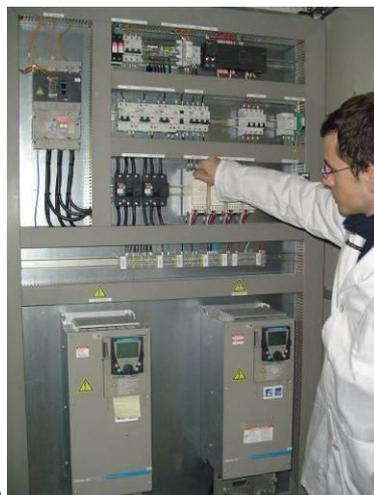
Se incluyen además armario eléctrico de control, de construcción metálica, protección IP55, con instalación de potencia, maniobra y señalización de todos los elementos de consumo eléctrico de la instalación.
