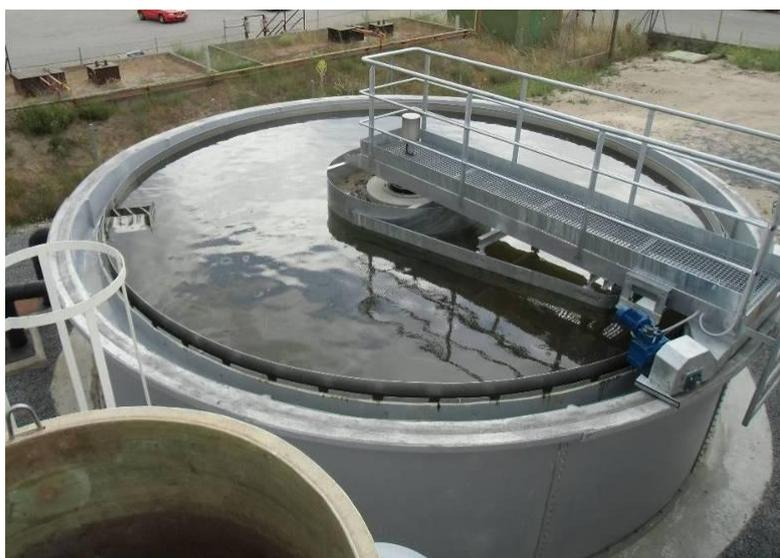
El sobrenadante, agua residual ya depurada, pasa por gravedad a la siguiente etapa ó a vertido a cauce público, mientras que los fangos son purgados. El recirculado y purga de fangos se logra mediante bombas centrífugas que envían el
