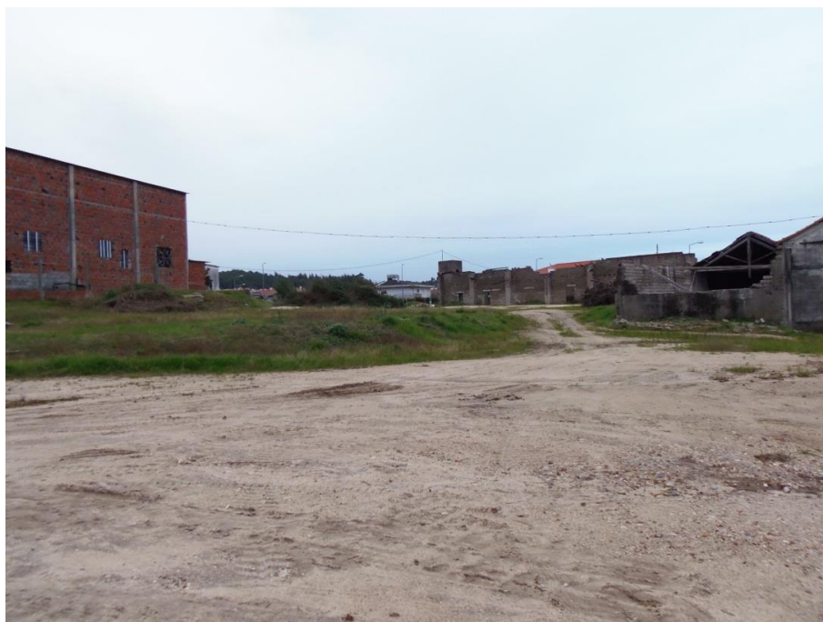
Figura 5 - Vista geral do local previsto para implantação do estaleiro (Estaleiro 2).
